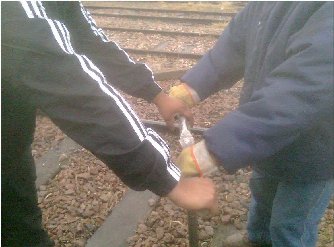
Tareas de ajuste y alineado de vía. Dicho trabajo consiste en ajustar los tornillos (tirafondos) dispuestos en los durmientes tomando el riel.
