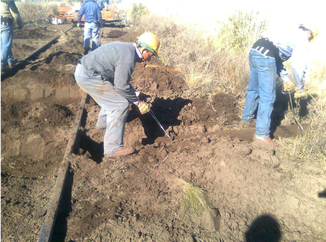
Se observan trabajos de cambio de durmientes, utilizando la metodología de manipulación de durmientes uso de tenazas para introducirlo en la vía, entre 2 operarios con el durmiente sostenido y soportado por ambos brazos, dispuesto entre las piernas de cada operario.
