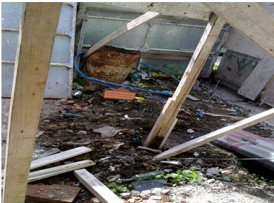
Imagen 39. Residuos en la Obra.
