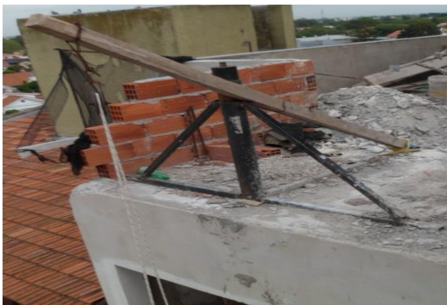
Imagen 9. Lateral del Edificio sin Protección con Pluma.
