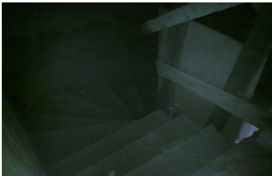
Imagen 32. Falta de Iluminación en Zona de Escaleras.
