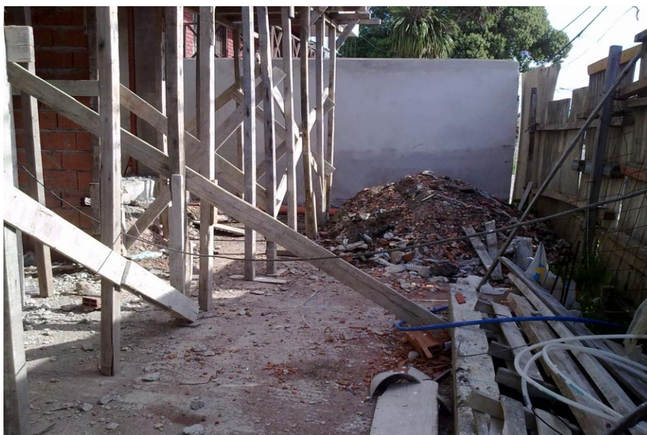
Imagen 37. Residuos en la Obra.
