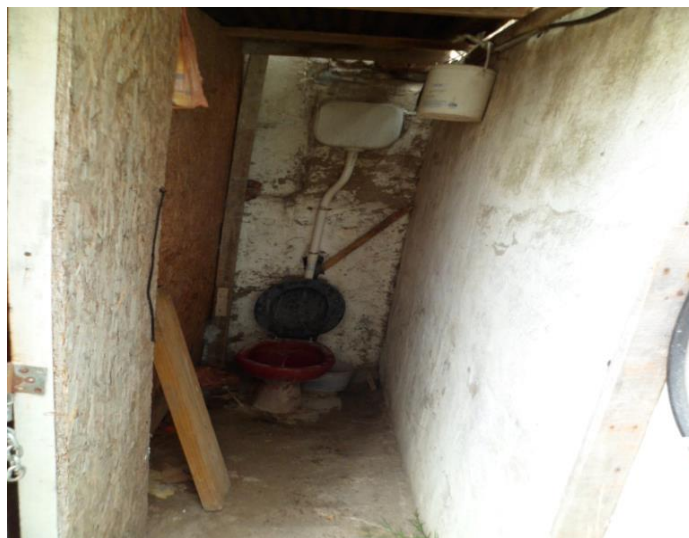
Imagen 33. Baño de Obra.
