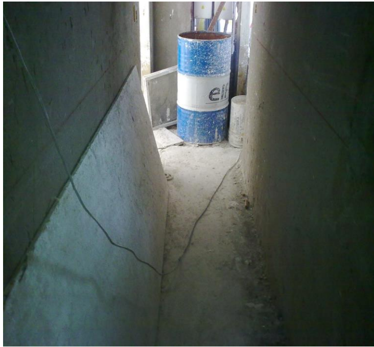
Imagen 45. Cableado obstruyendo Vías de Circulación.
