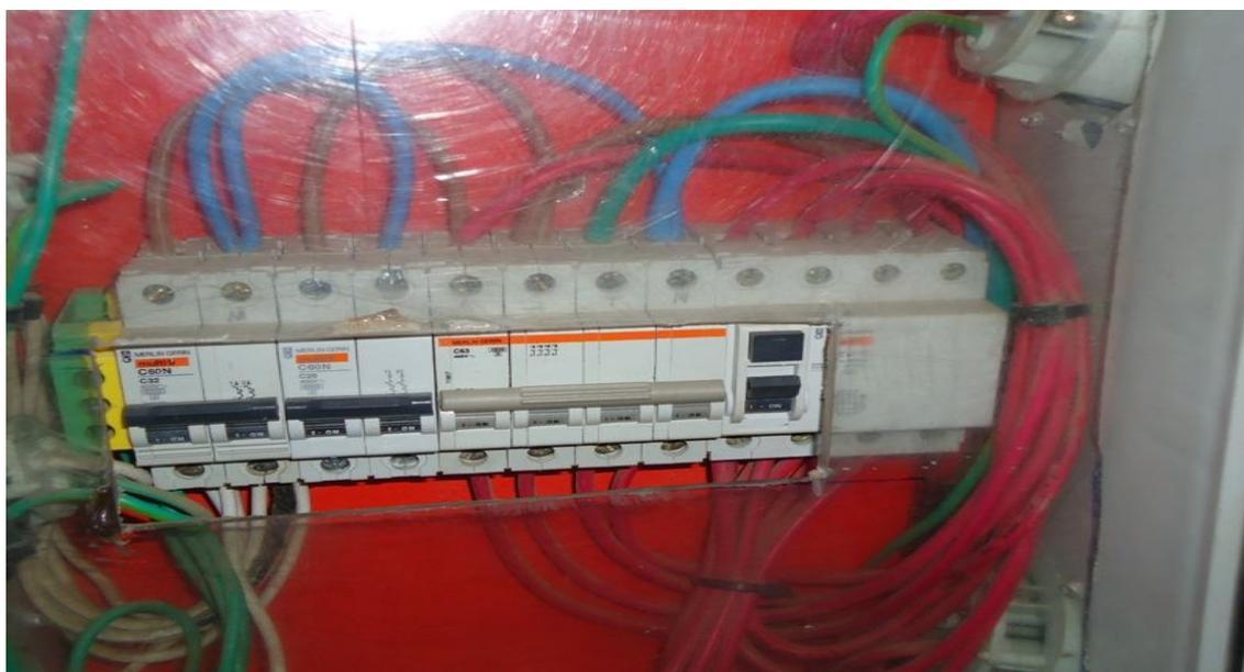
Imagen 8: tablero utilizado, con disyuntor diferencial de 30 miliamper, termo magnética de 32 Amper y protección mecánica del interior del mismo.
