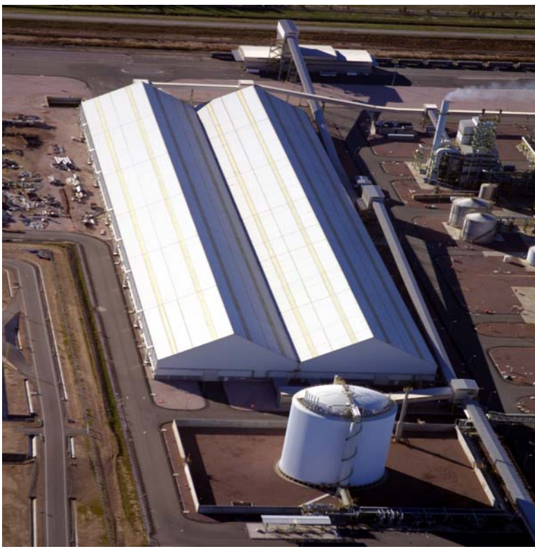
Silos de Urea
