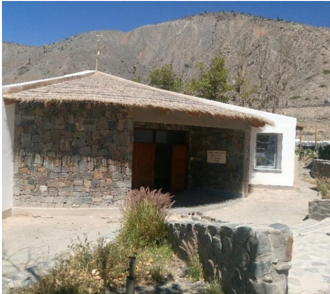
Figura 9. Puerta de ingreso. Colegio Secundario N°8214. Elaboración propia. (2019)
