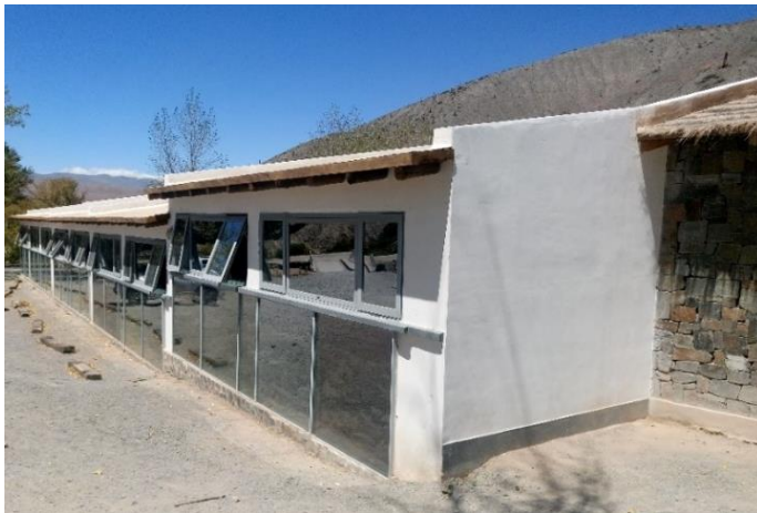
Figura 10. Muros Trombe en aulas. Colegio Secundario N°8214. Elaboración propia. (2019)
