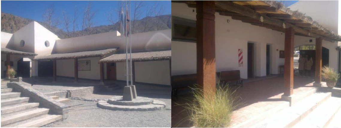
Figuras 11 y 12. Patio y galería del Colegio Secundario N°8214. Elaboración propia. (2018)
