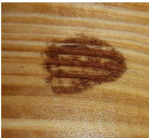
Lavado madera con agua fría
