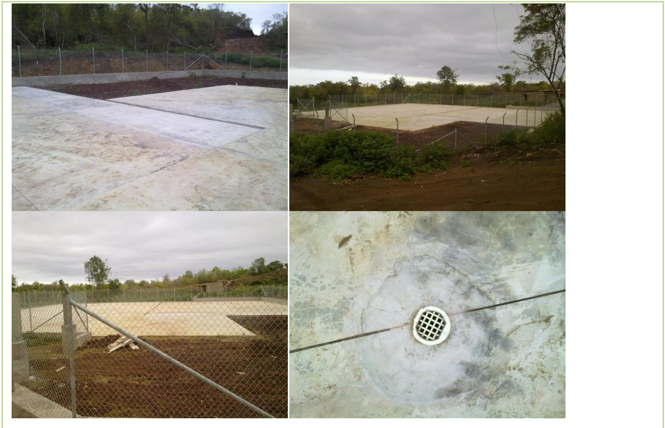
Figura 11.2. Imágenes de la futura planta de compostaje recientemente construida, sobre la base de lo propuesto en este proyecto final.
