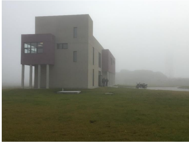
Imagen 1: Edificio central, EDAR.
