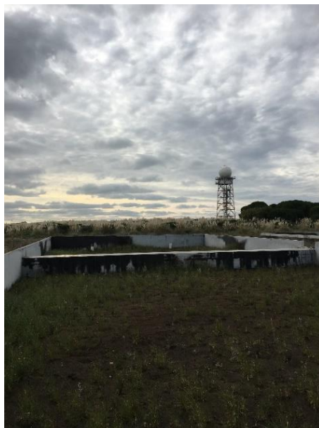
Imagen 10: Piletas de filtrado biológico, EDAR.
