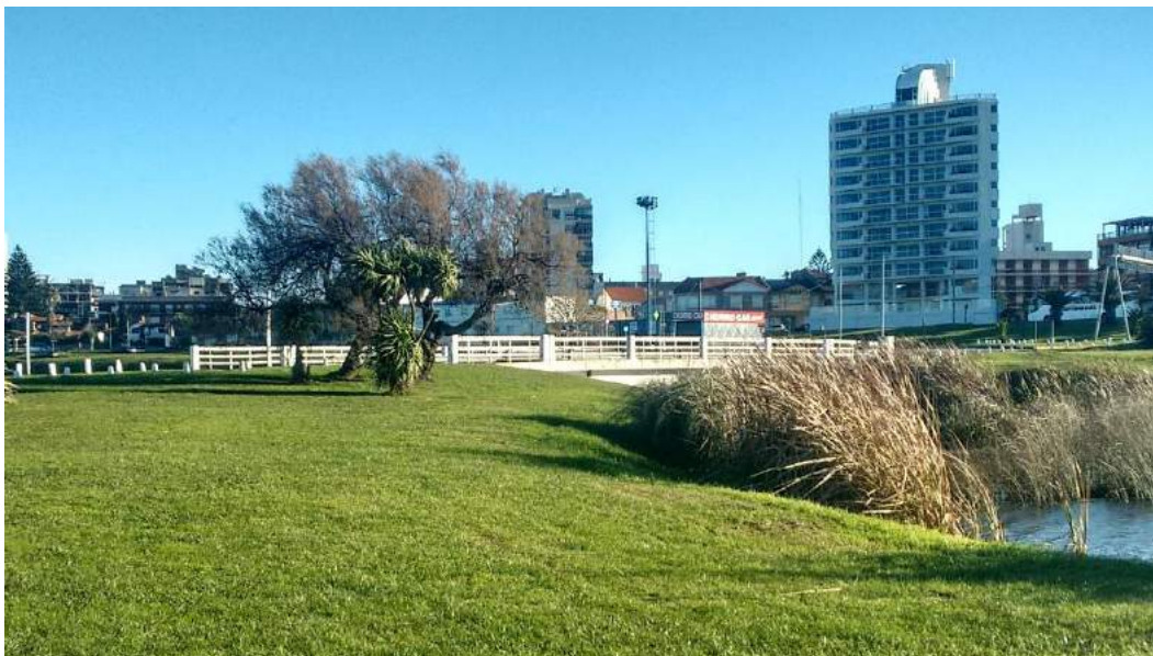
Figura 24.4 – Cuarto puente que atraviesa las lagunas de PM.
