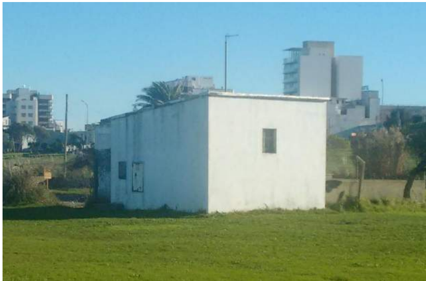
Figura 34.1 – Estructura edilicia de pequeño porte en las lagunas de PM.
