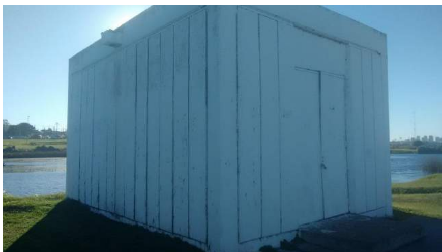
Figura 34.2 – Estructura edilicia de pequeño porte en las lagunas de PM.
