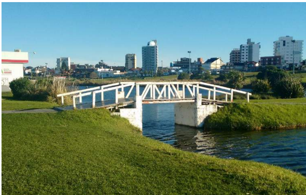
Figura 24.3 – Tercer puente que atraviesa las lagunas de PM.
