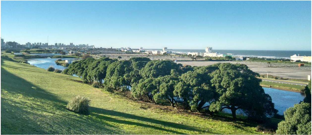
Figura 27.1 – Acceso libre de las lagunas de PM.
