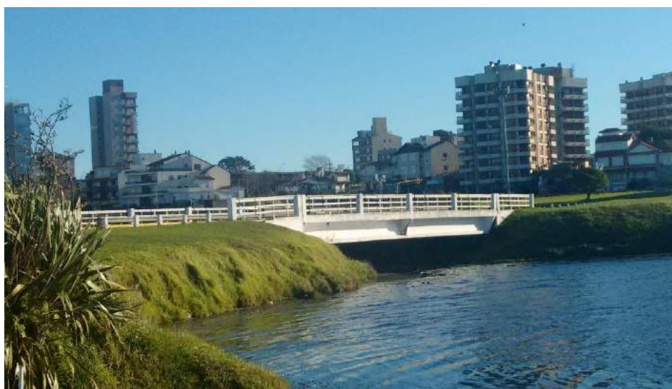
Figura 24.1 – Puente al N de las lagunas de PM.
