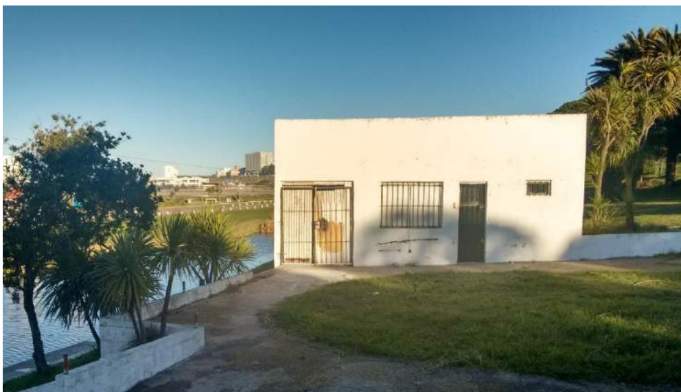
Figura 34.4 – Estructura edilicia de pequeño porte en las lagunas de PM.
