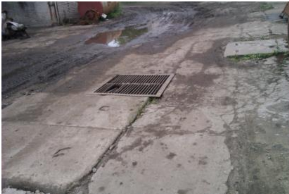
Pisos sector de taller mecánico
