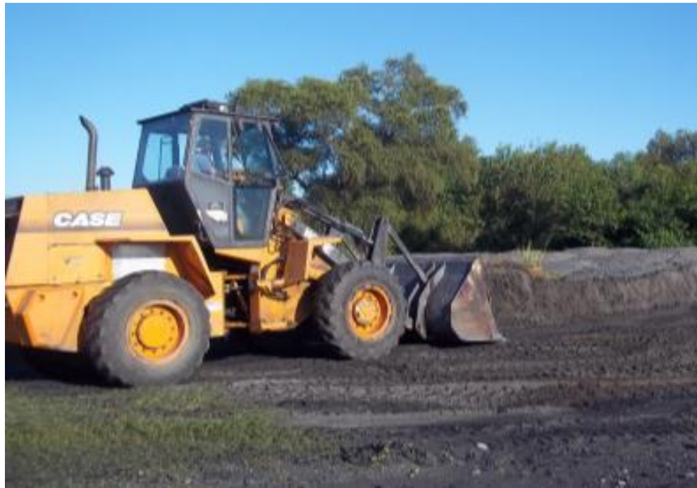
sector piletones de sedimentación
