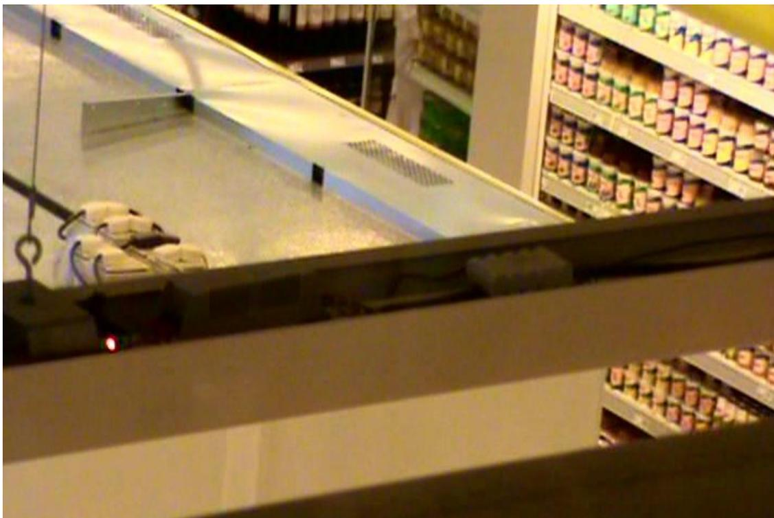
En esta foto se puede apreciar un LED rojo el cual indica q las pilas se encuentran con carga, estas son triple a y son un conjunto de pilas unidas las cuales abastecen la energía
