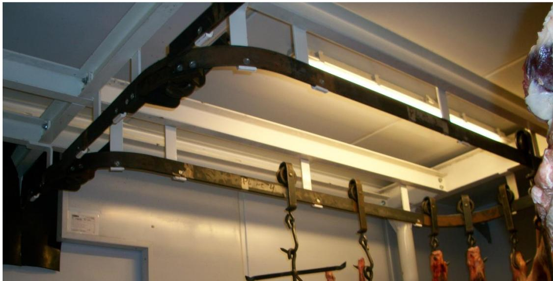
Para evitar que los empleados realicen el usual sobre esfuerzo de cargar carne al hombro se utiliza el siguiente sistema de polea.
