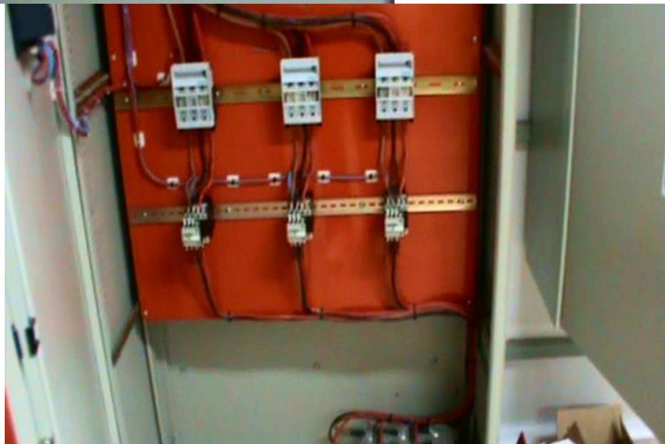
**En la fotografía se ve que hay un seccionador por cada una de las fases. Estos poseen protección**
