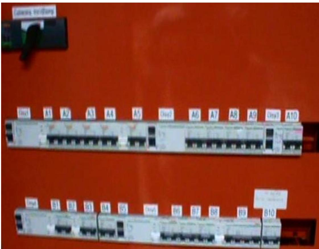
En el tercer gabinete se puede apreciar cómo se distribuye la energía a cada uno de sus puntos. Cada línea posee un disyuntor diferencial.
