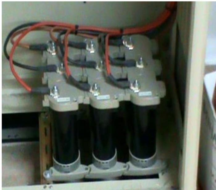
El capacitor es un dispositivo que almacena carga eléctrica; este está formado por dos conductores próximos uno a otro, separados por un aislante, de tal modo que puedan estar cargados con el mismo valor, pero con signos contrarios.
