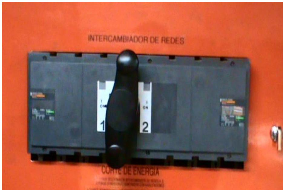
El intercambiador de redes es una cuchilla que tiene como función desactivar la red para que posteriormente entre la energía del generador. Estas cuchillas fueron hechas para que puedan ser manipulados por lo operarios del lugar (con un previo conocimiento) en caso de que se produzca un corte de luz. Se acciona en sentido horario hasta que la cuchilla cambie de posición.
