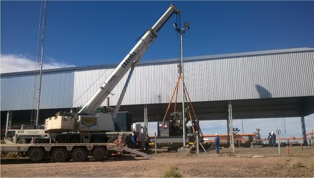
FIG32- Izaje de Motocompresor con interferencia eléctrica.
