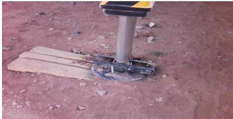
**FIG22-**Colocación de tacos de madera de compensación.
