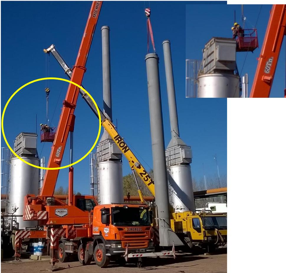
FIG42: Operarios realizando el reemplazo de la junta.
