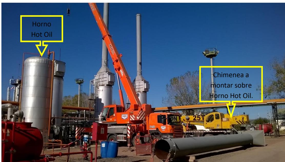
FIG37: Grúas paralelas para el izaje de la chimenea.
