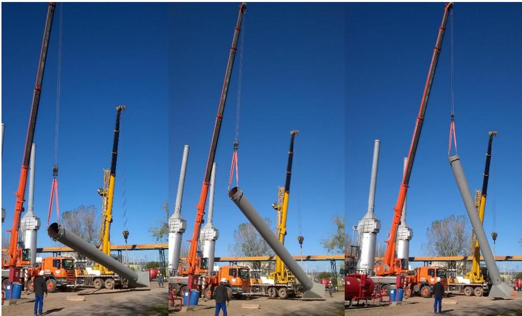
FIG39: Secuencia de posicionamiento vertical de la chimenea.
