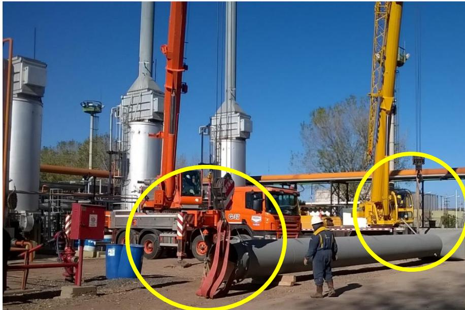
FIG38: Extremos de chimenea con faja de 5TNL y cáncamos.
