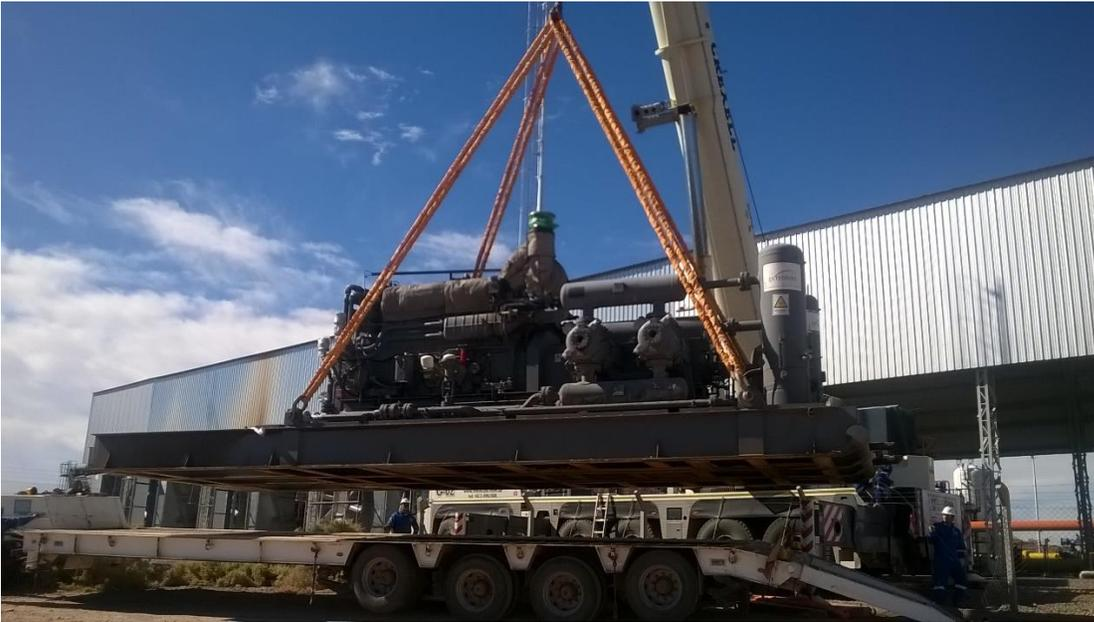
FIG33- Motocompresor montándose sobre camión con carretón.
