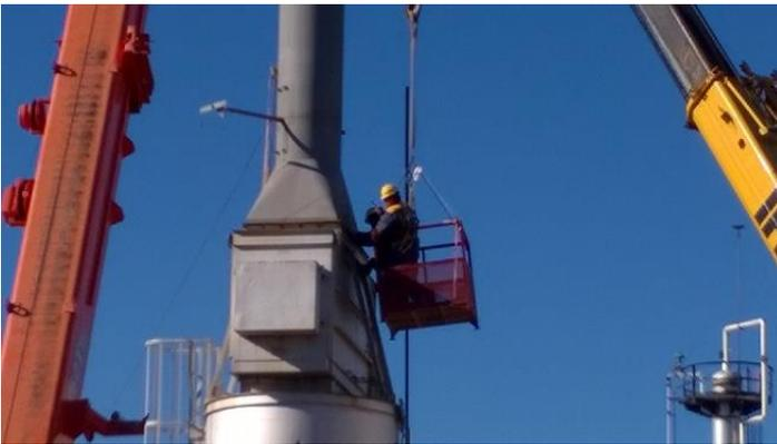
FIG44: Operarios realizando el ajuste de bulones.
