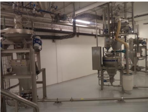
Sala de transporte neumático de los polvos
