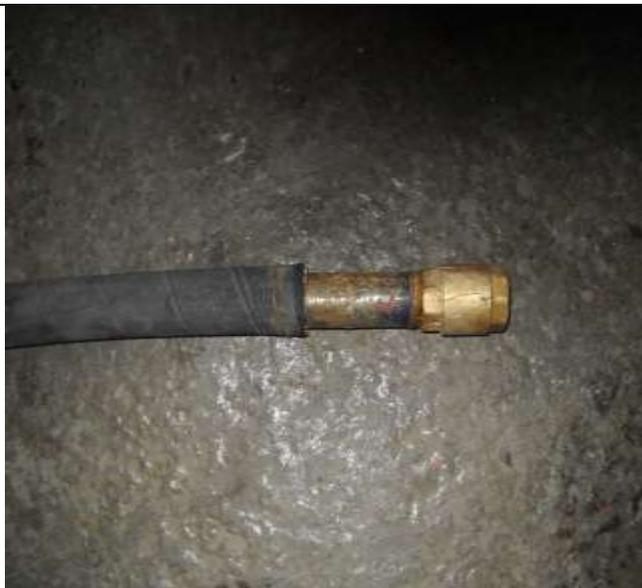
Válvula de retención atada con alambre, además la misma se observó con la retención rota lo cual llevo al operario de mantenimiento a succionar. El operador de mantenimiento no avisa del desperfecto del equipo. **Cabe aclarar que al operario le dieron 1 solo día de reposo por prevención con una dieta a seguir.**
