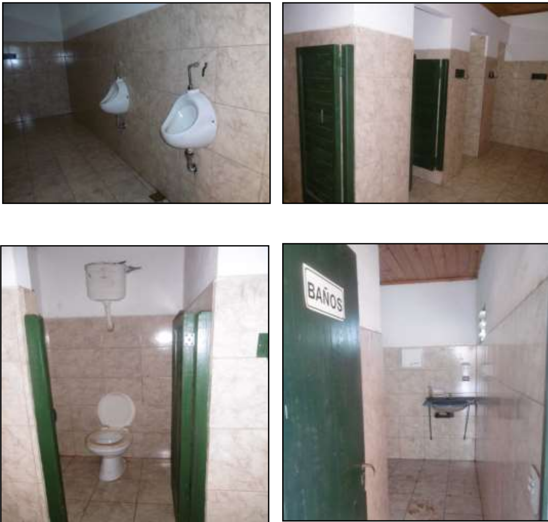
Figura 3.9.: Sector Baños, Aserradero.
