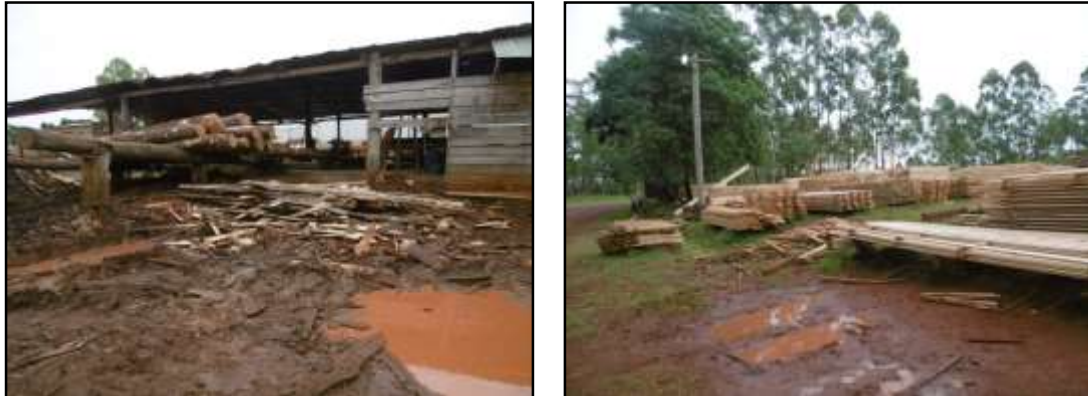
Figura 3.35.: Aguas residuales, Aserradero.
