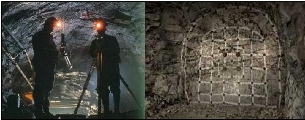
**Fig. 19: Medición y Marcado de malla para perforación**
