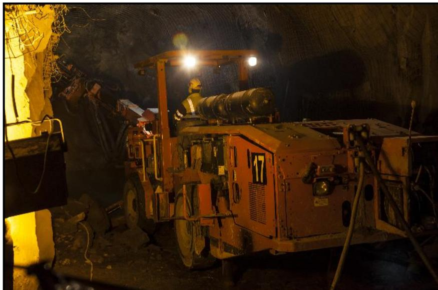
**Fig. 22: Jumbo perforando el frente**
