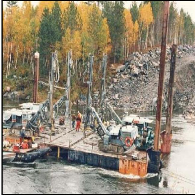
**Fig 19: Perforación con recubrimiento**
