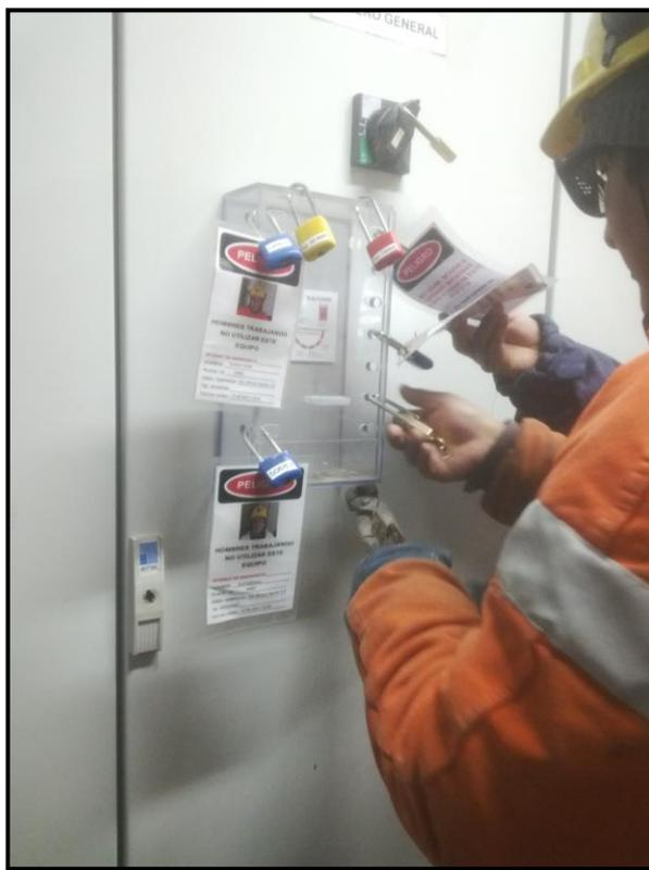
**Fig 48: Personal aplicando procedimiento de bloqueo**
