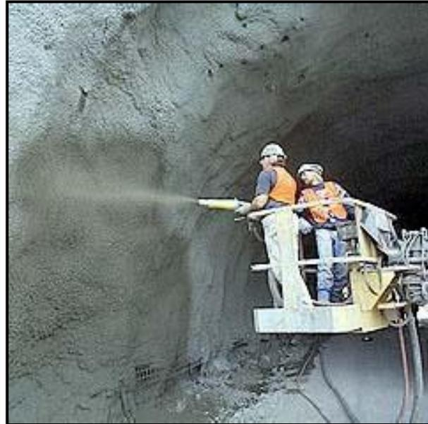
**Fig 13: Fortificación: explotación Sub Level Stopin.**
