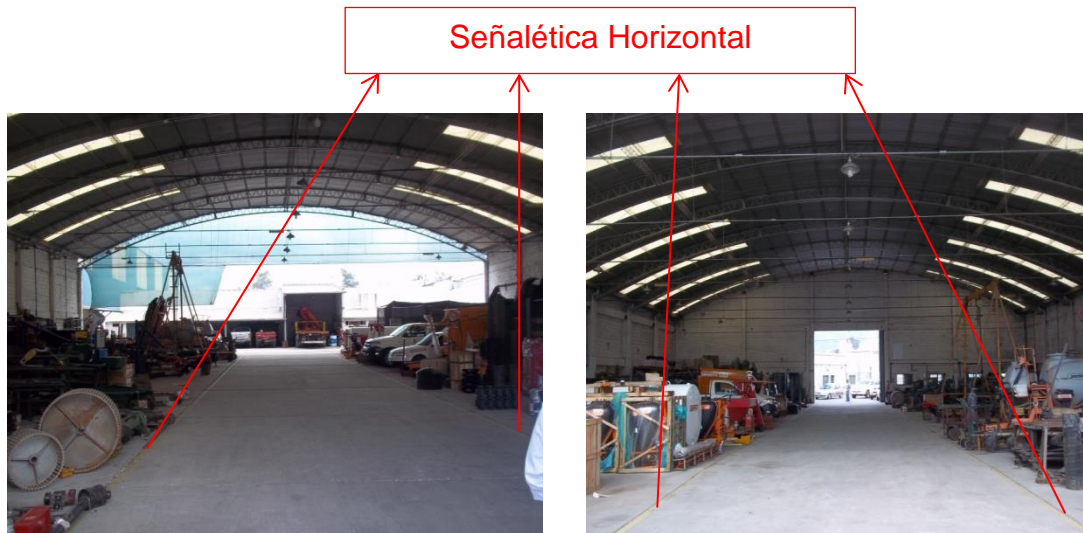
Fig. 33 Vista desde el ingreso
