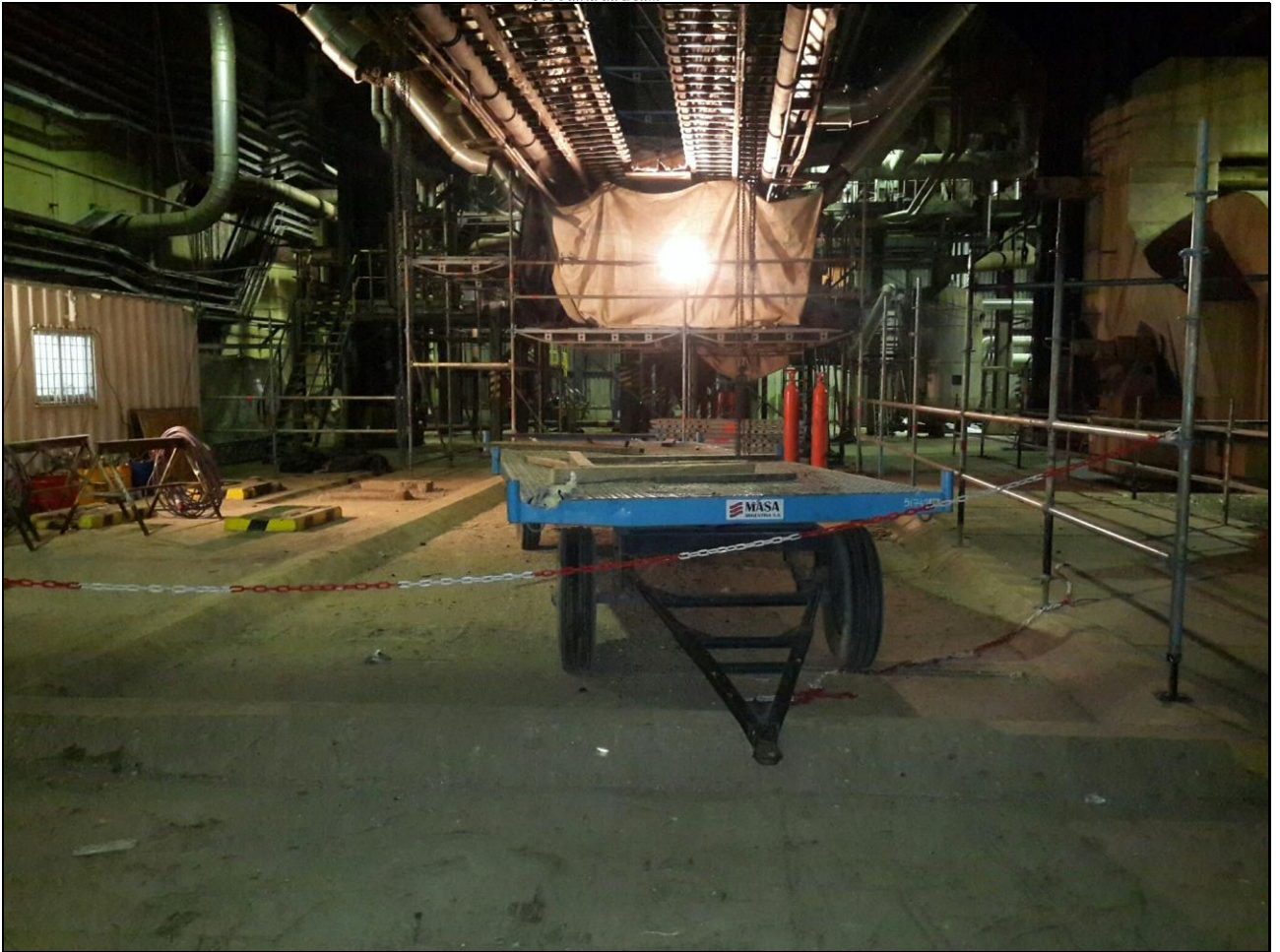
Cenicero despejado y sistema de andamiaje interno
