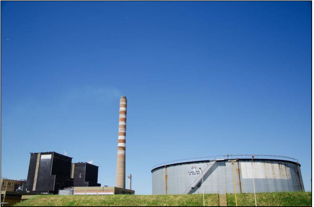
Tanque de fuel oil de 30.000 m3 de capacidad
