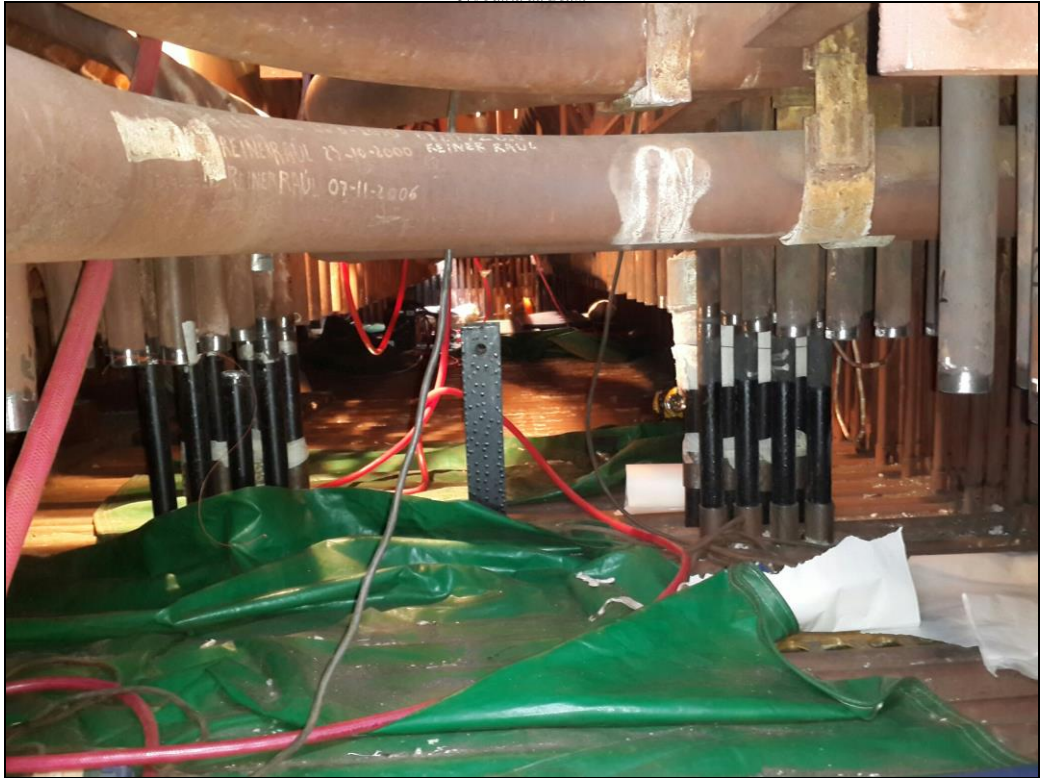
Montaje de serpentina
