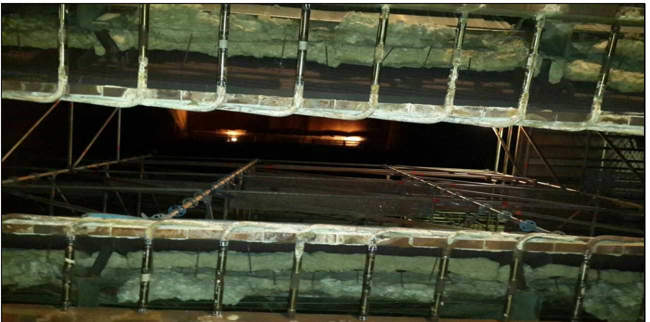
Sistema de andamiaje interno, vista desde nivel cero (cenicero).
