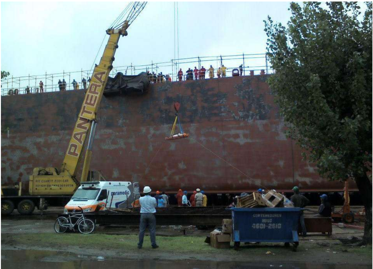
Accidente de caída en altura dentro del buque
