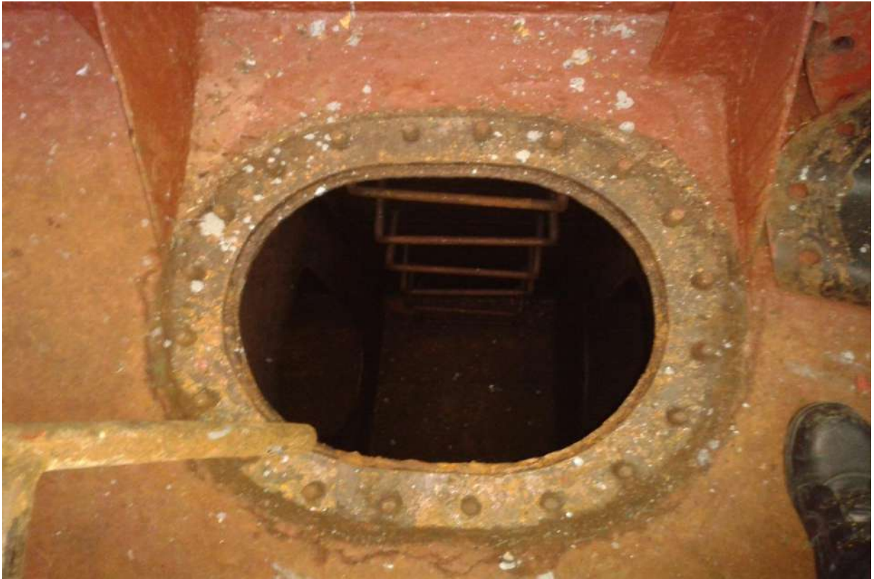
Vista interior de un espacio confinado
