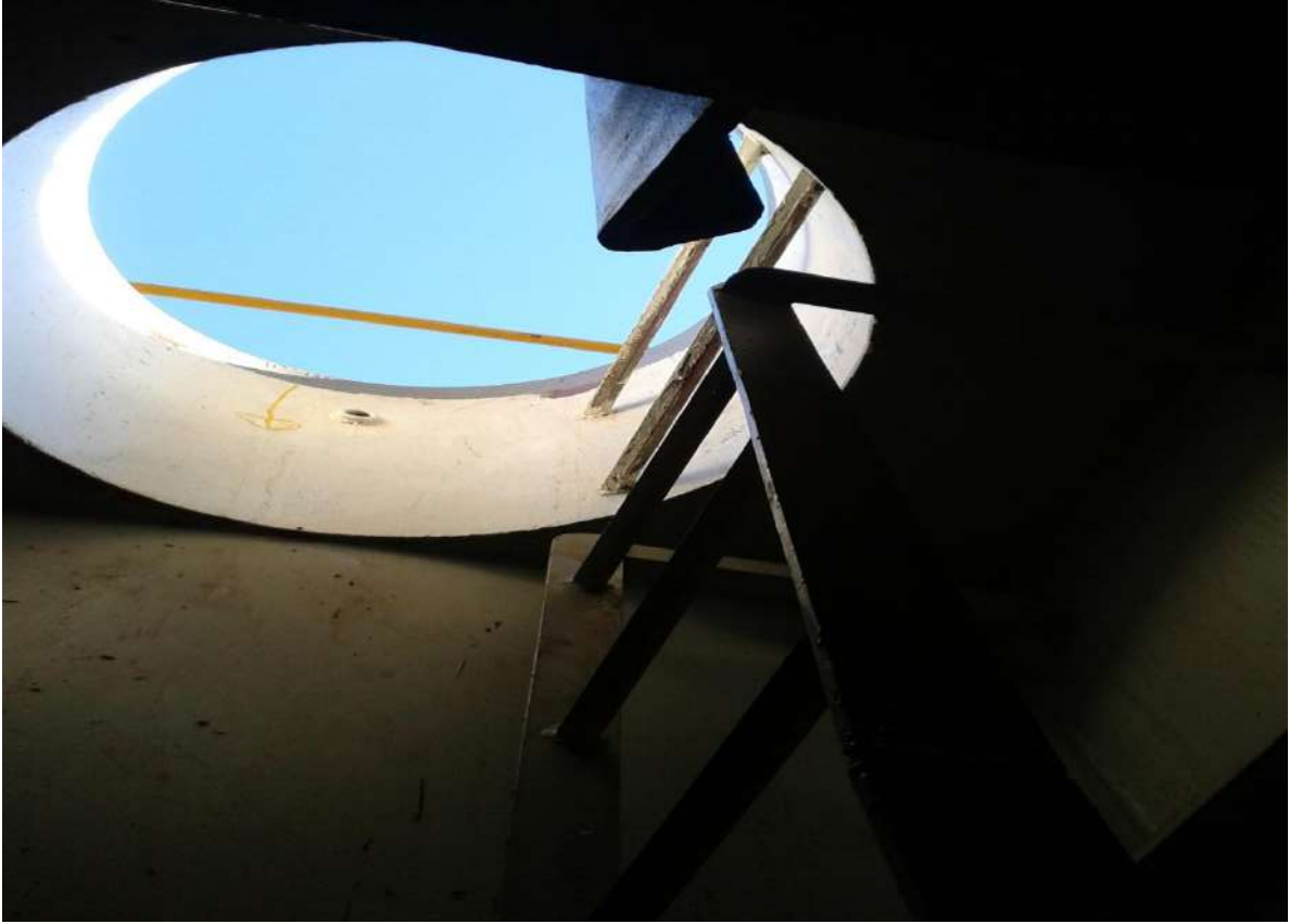
Dentro del espacio confinado
