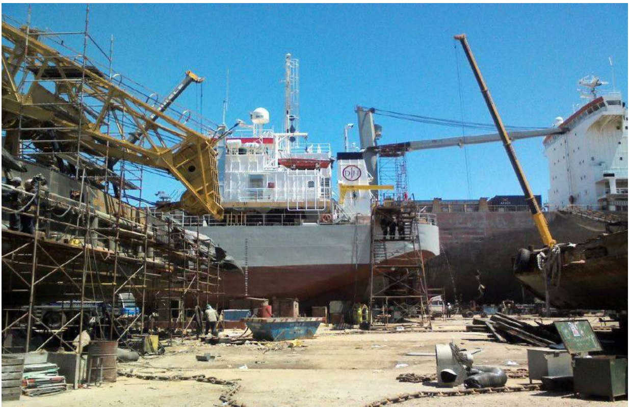
Soldadores trabajando en la grúa
