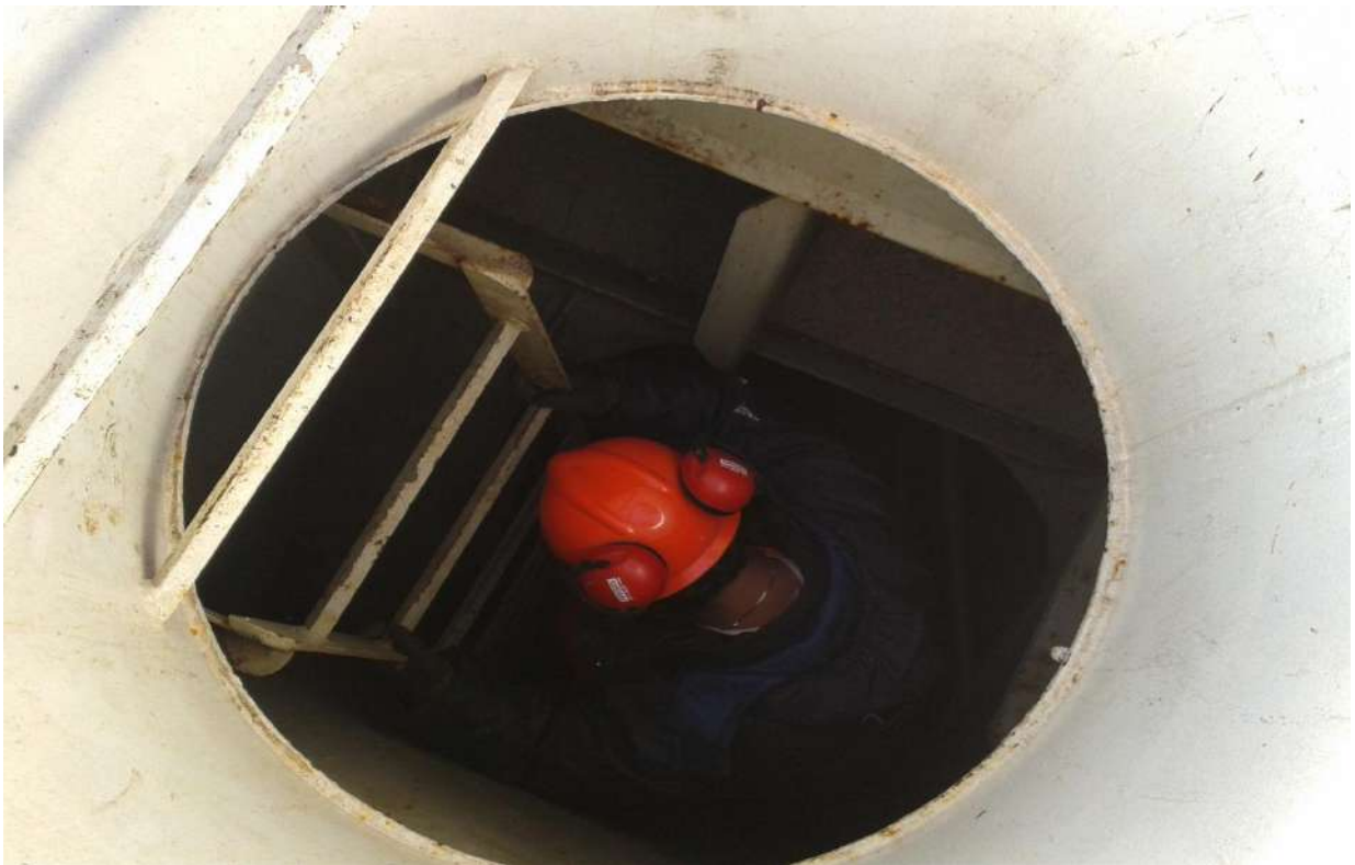
Ingreso a un espacio confinado
