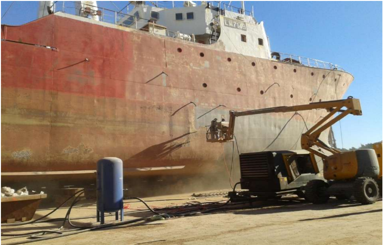
Arenado Sandblasting (proyección de arena por medio de aire a presión)
