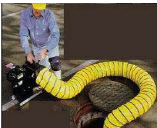
Fig. 5: Ventilación continua
