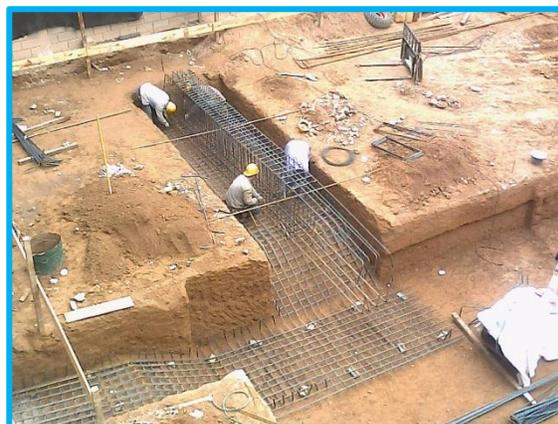
El operario armador, realiza el armado de armaduras, existen tareas de plegado hierro para el armado de armaduras, atado de hierros (ya plegados) según requerimientos de producción.
