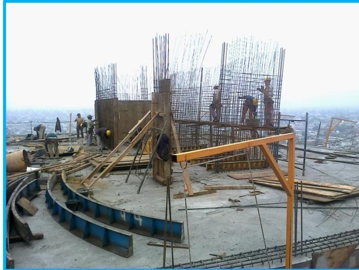
El operario carpintero, realiza el de encofrados de armadura de hierro, ejecutando cortes en paneles fenólicos, puntales de madera, a medida atando con alambre, nivelando y apuntalando.
