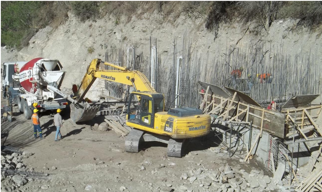
Imagen 23 - Llenado del sexto nivel de muro derecho y contrafuertes aguas arriba utilizando Mixer y Komatsu PC 200
