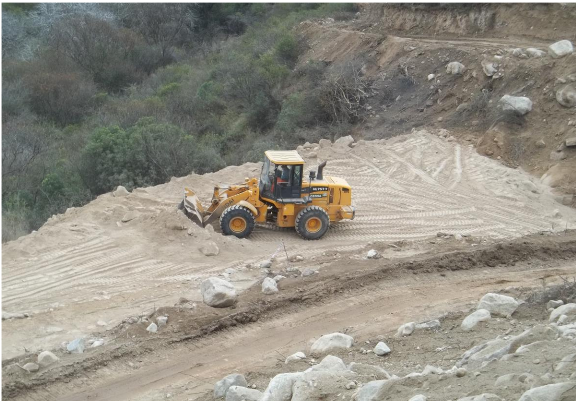
Imagen 9: Pala Cargadora Hyundai 757-7 realizando movimientos de suelo en Desarenador
