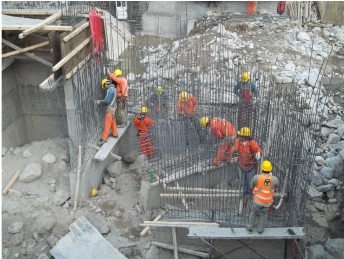
Imagen 19- Armadura fundición muro izquierdo aguas arriba
