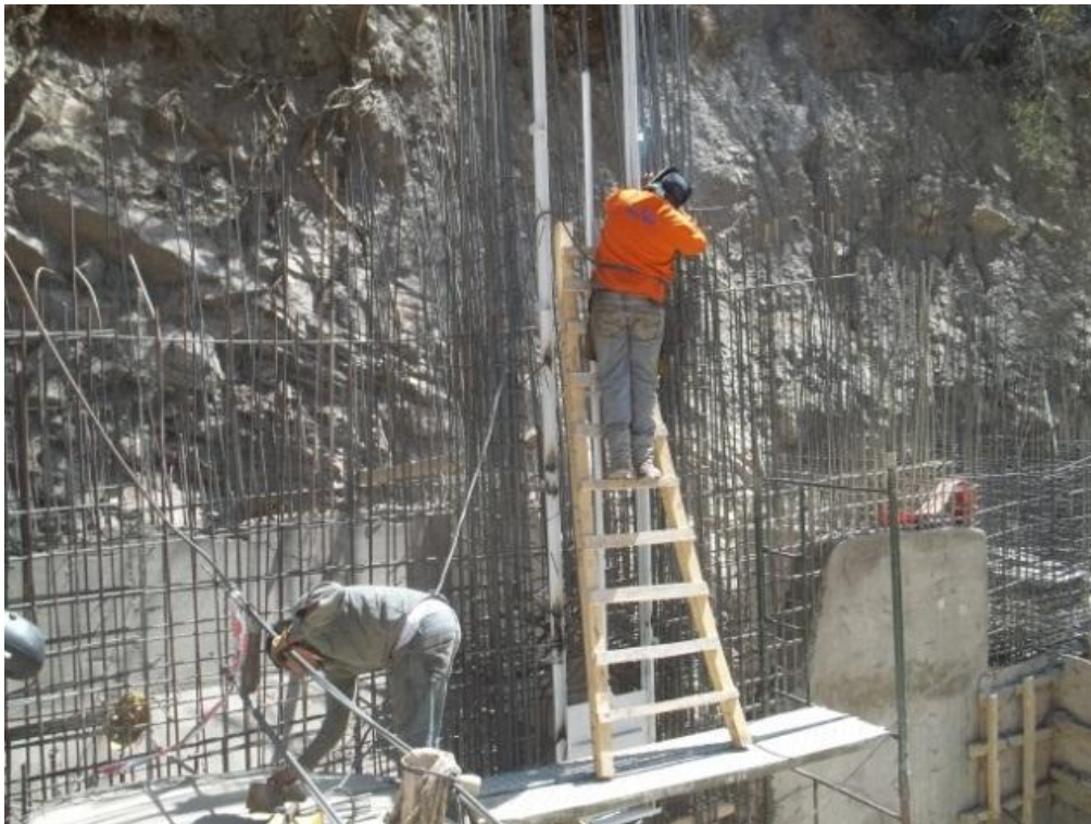
Imagen 13 – Utilización de escalera para colocación de compuertas sobre armadura de hierro
