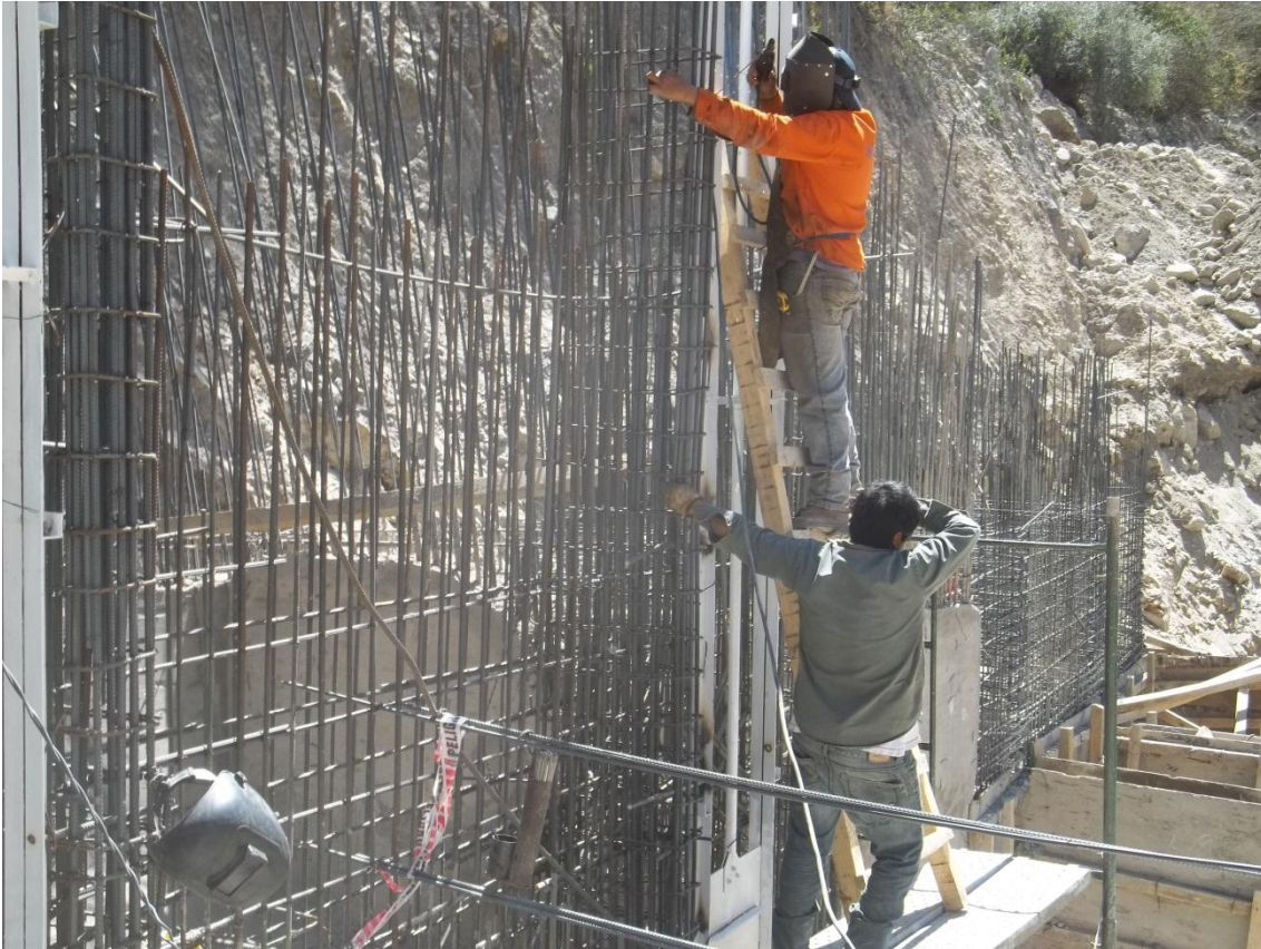
Imagen 25 – Operación de soldadura eléctrica de armadura para colocación de compuertas
