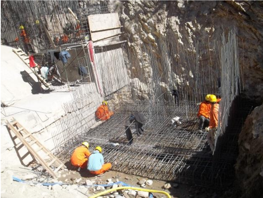
Imagen 17- Armadura de la fundación del muro derecho aguas arriba
