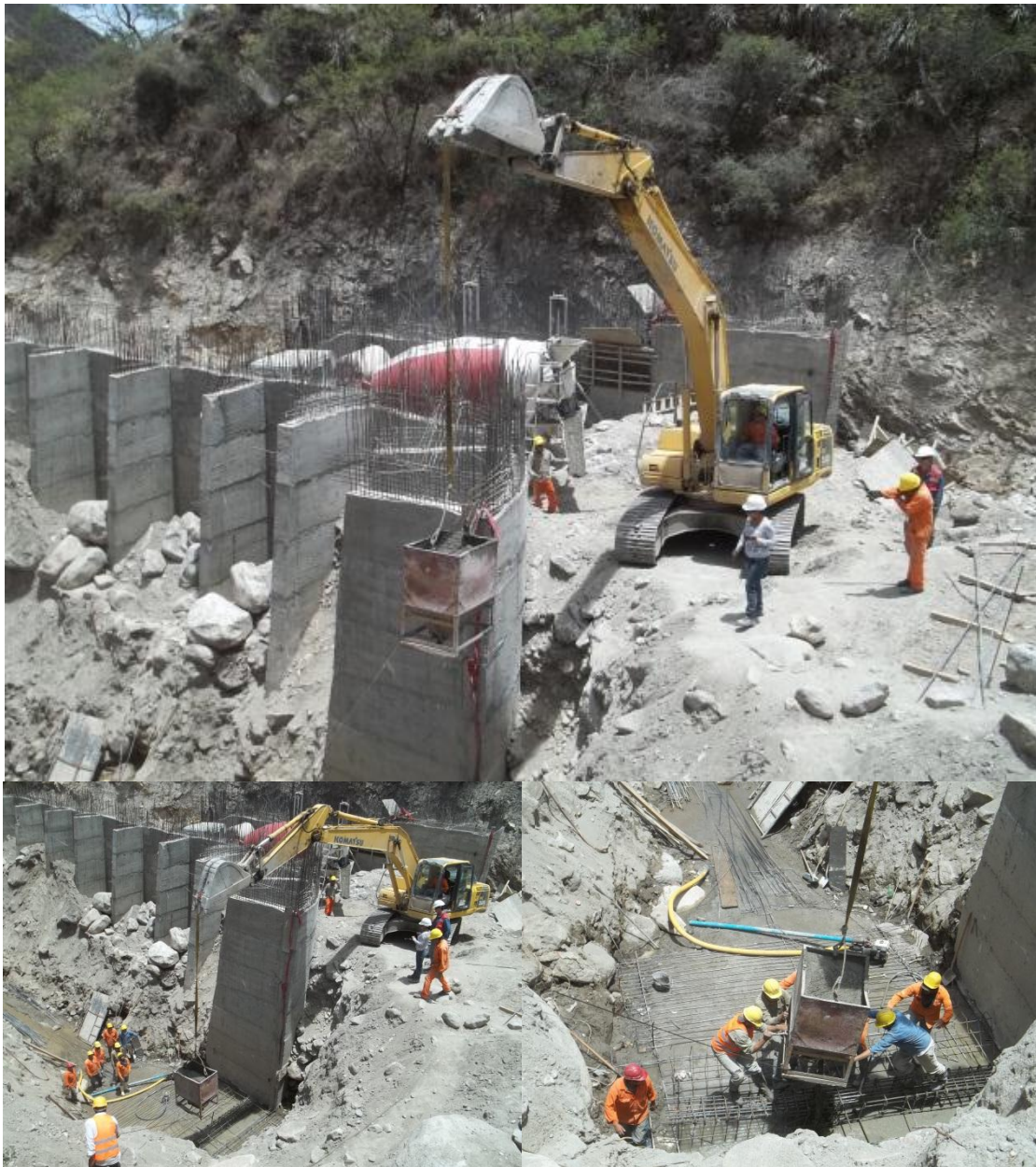
Imagen 12 – Bajado de balde con hormigón en la operación de hormigonado de loza inferior Muro contención derecho
