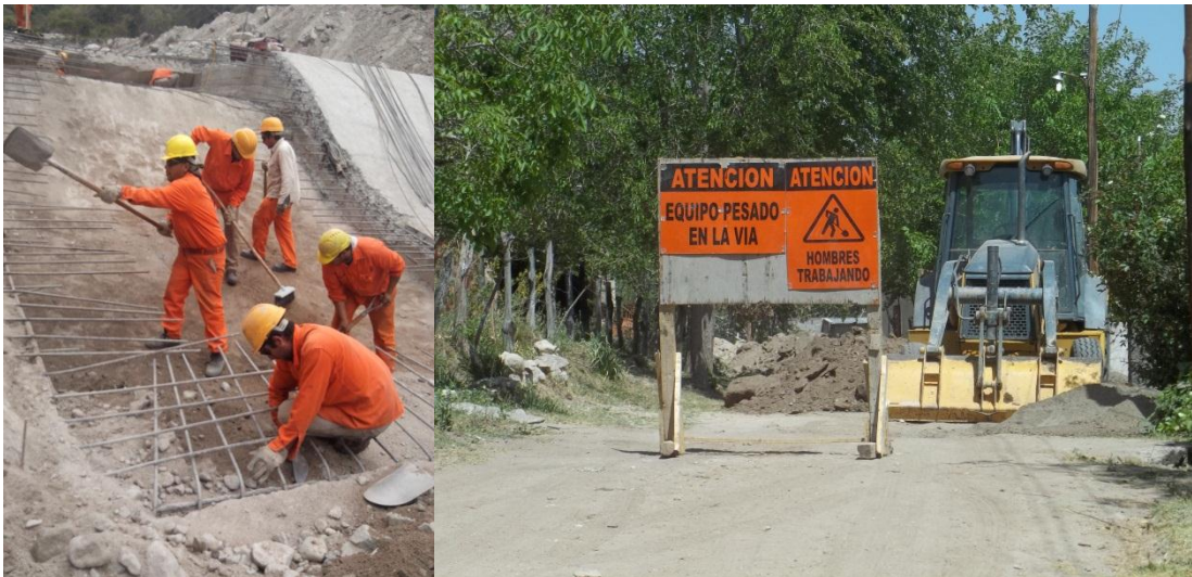
Imagen 15 – Excavación manual y con maquinas
