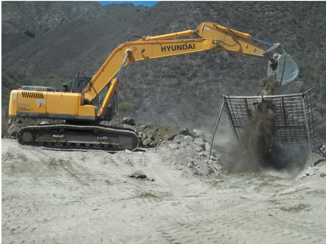
Imagen 8: Retro Hyundai 250 grillando material de cantera
