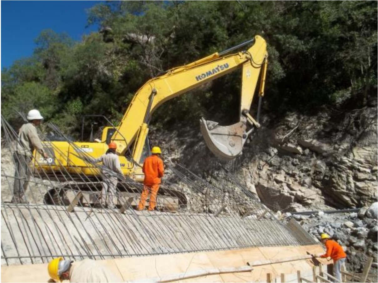
Imagen 6: Armadura y Encofrado Azud 1ª Etapa
