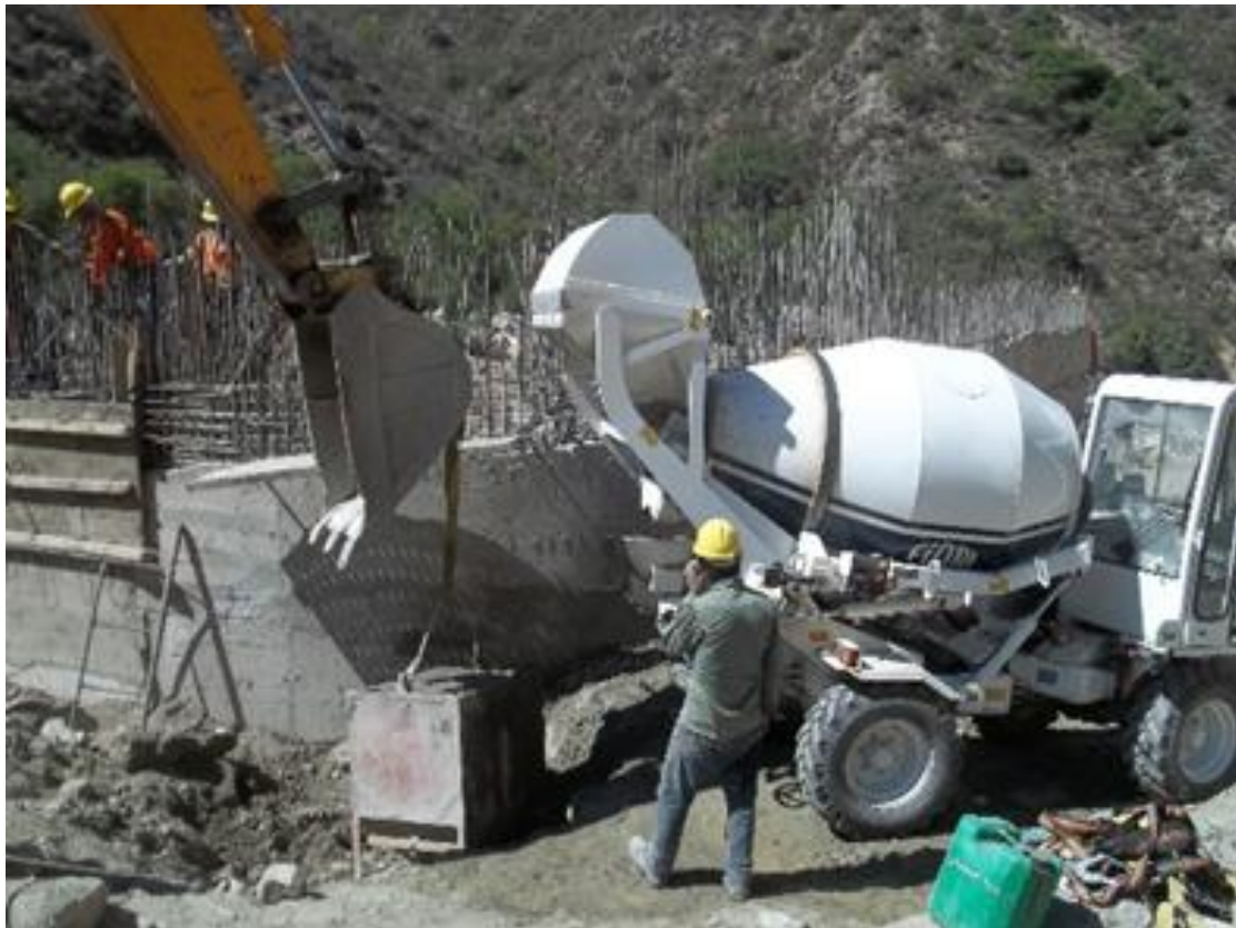
Imagen 33 – Motohormigonera Fiori en operación de hormigonado parte del muro izquierdo aguas arriba
