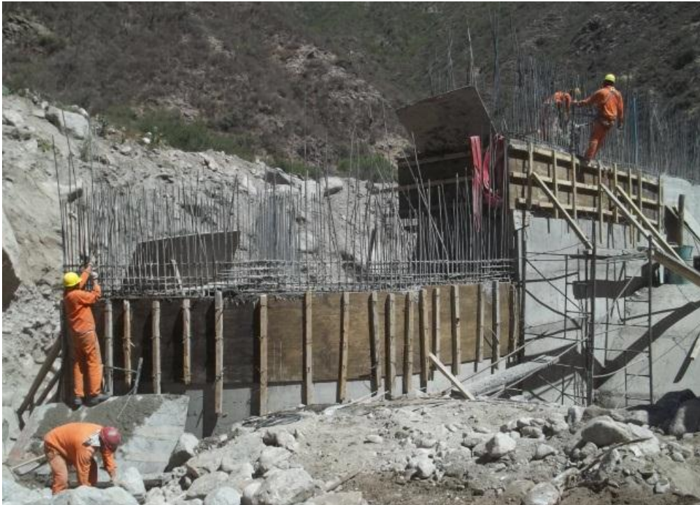
Imagen 22 –Encofrado cuarto nivel curva y contrafuertes muro izquierdo aguas arriba y encofrado sexto nivel muro central y contrafuertes
