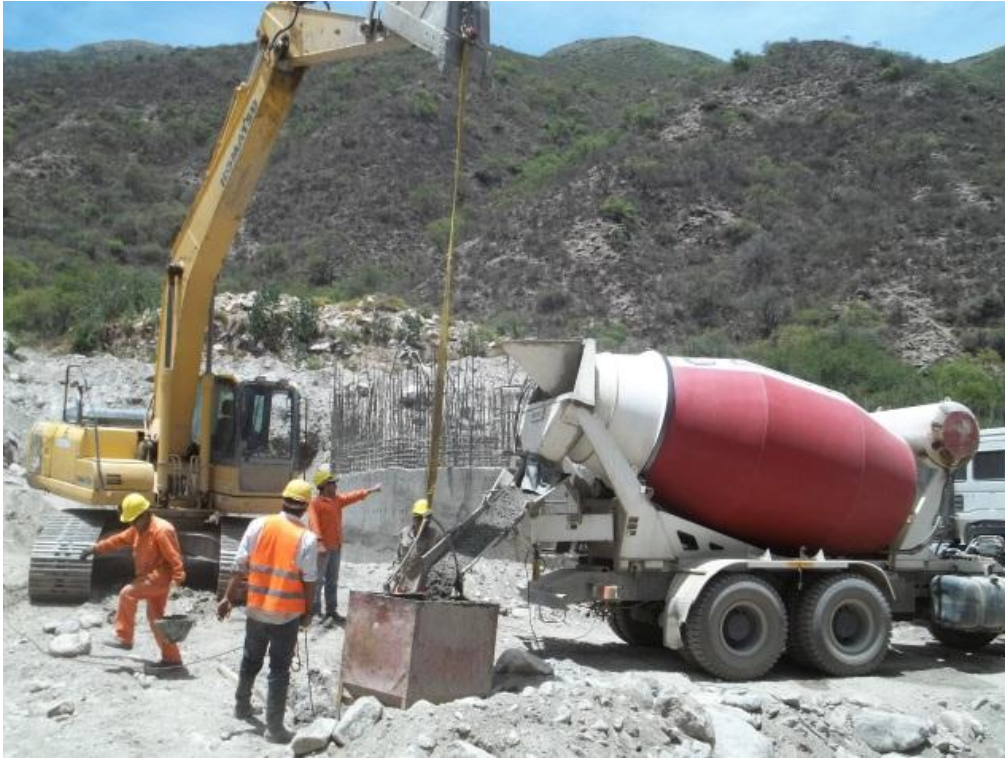
Imagen 11 - Izado de balde con hormigón H21 para hormigonado nivel 3 Muro de contención derecho aguas arriba
