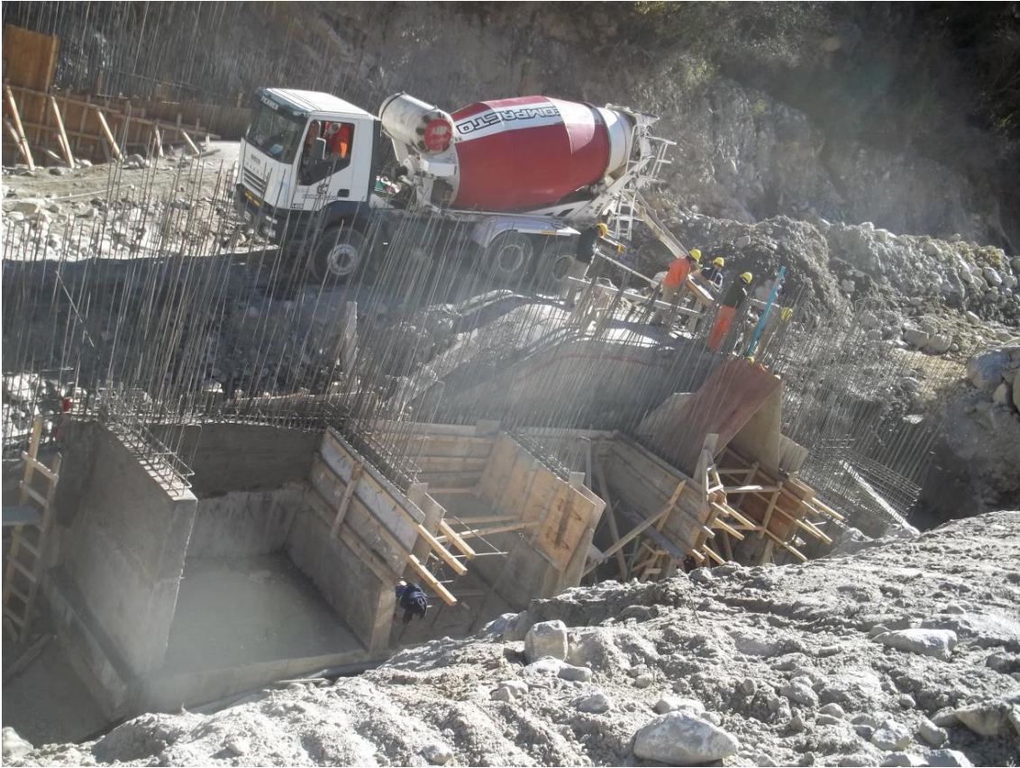
Imagen 30 - Llenado de una parte del muro izquierdo y contrafuertes Mixer Iveco
