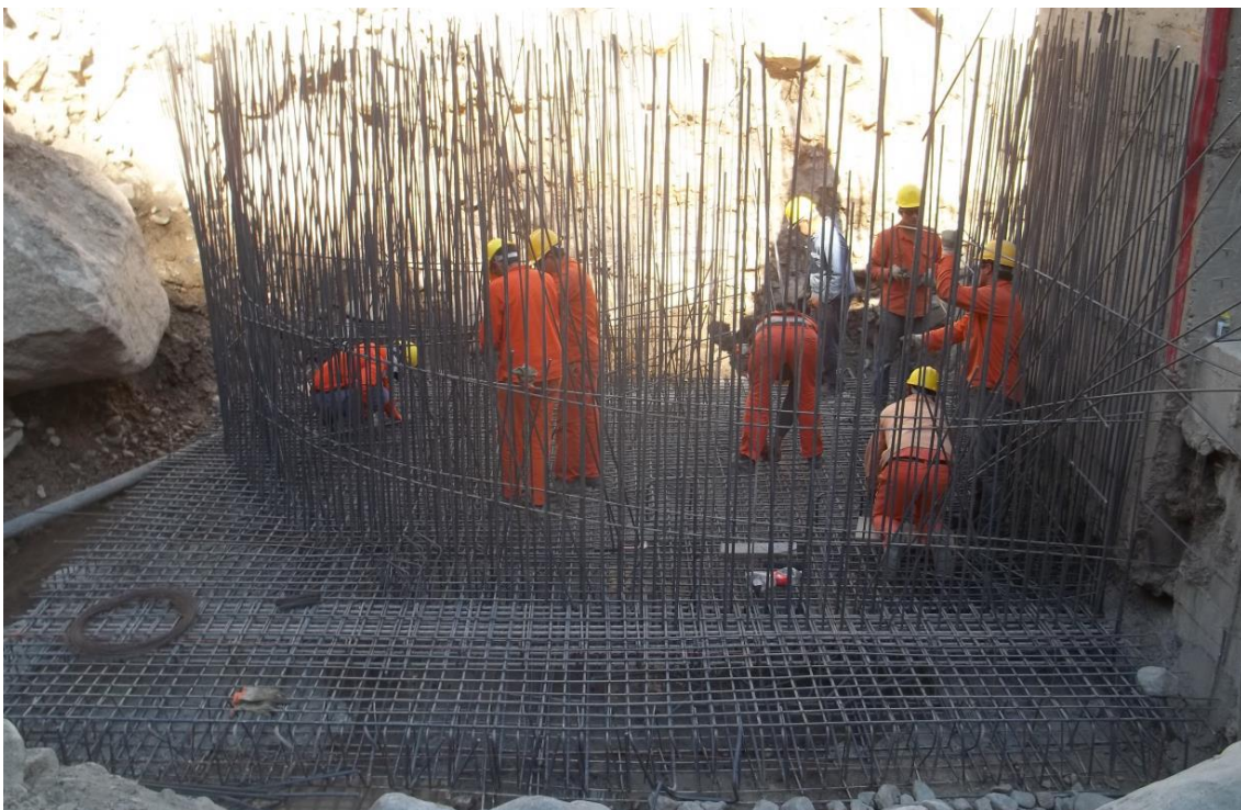
Imagen 20 – Armadura fundición primer nivel muro izquierdo aguas arriba
