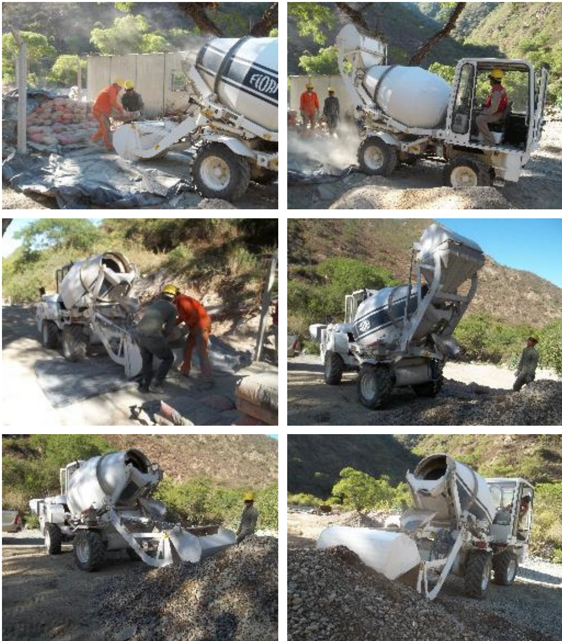
Imagen 32 - Secuencia de cargado de Motohormigonera Fiori para la elaboración de Hormigón
