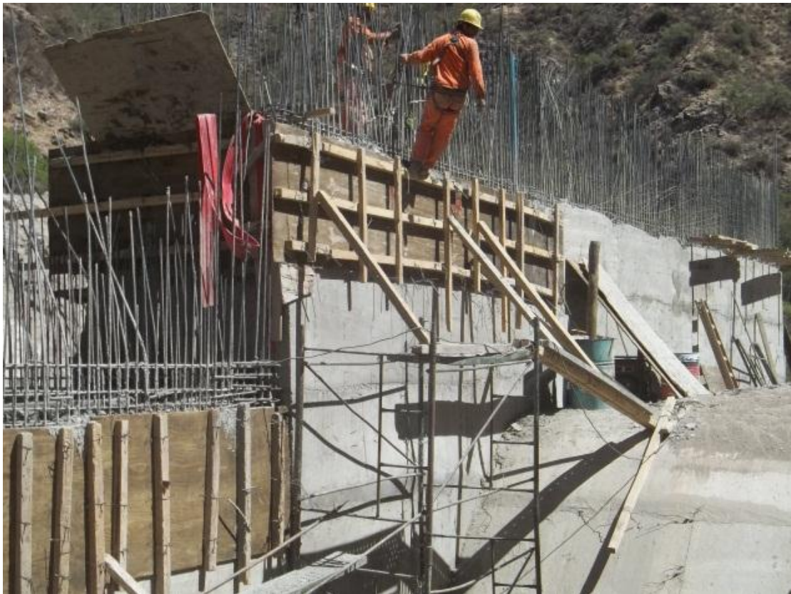
Imagen 21- Encofrado sexto nivel del muro izquierdo y contrafuertes parte central
