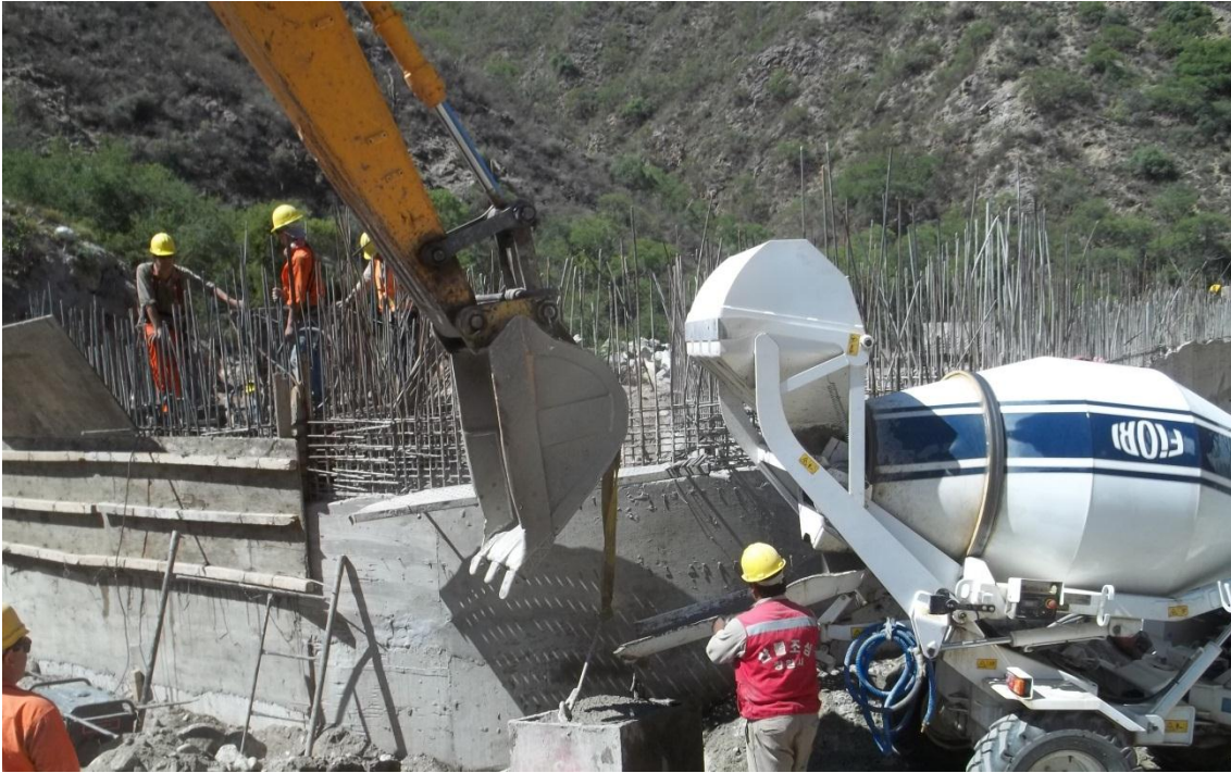
Imagen 24 - Hormigonado hasta el sexto nivel de la curva del muro izquierdo y contrafuertes aguas arriba utilizando Motohormigonera Fiori y Komatsu PC 200
