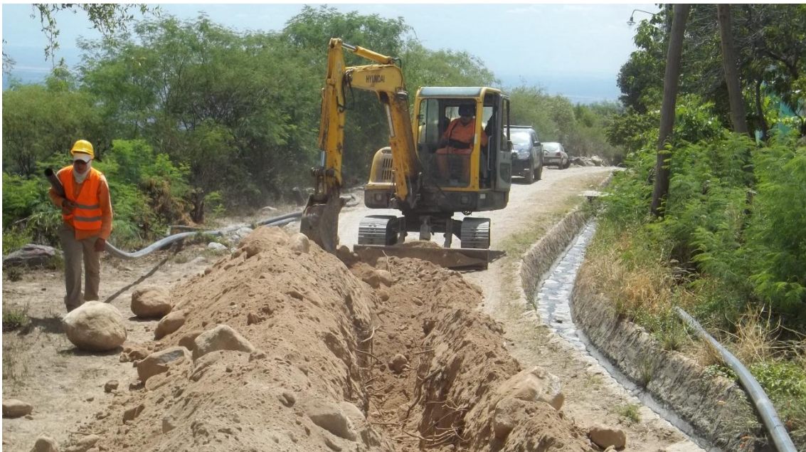
Imagen 16 – Excavación con Hyundai 55-7 para colocación de cañería de PRFV
