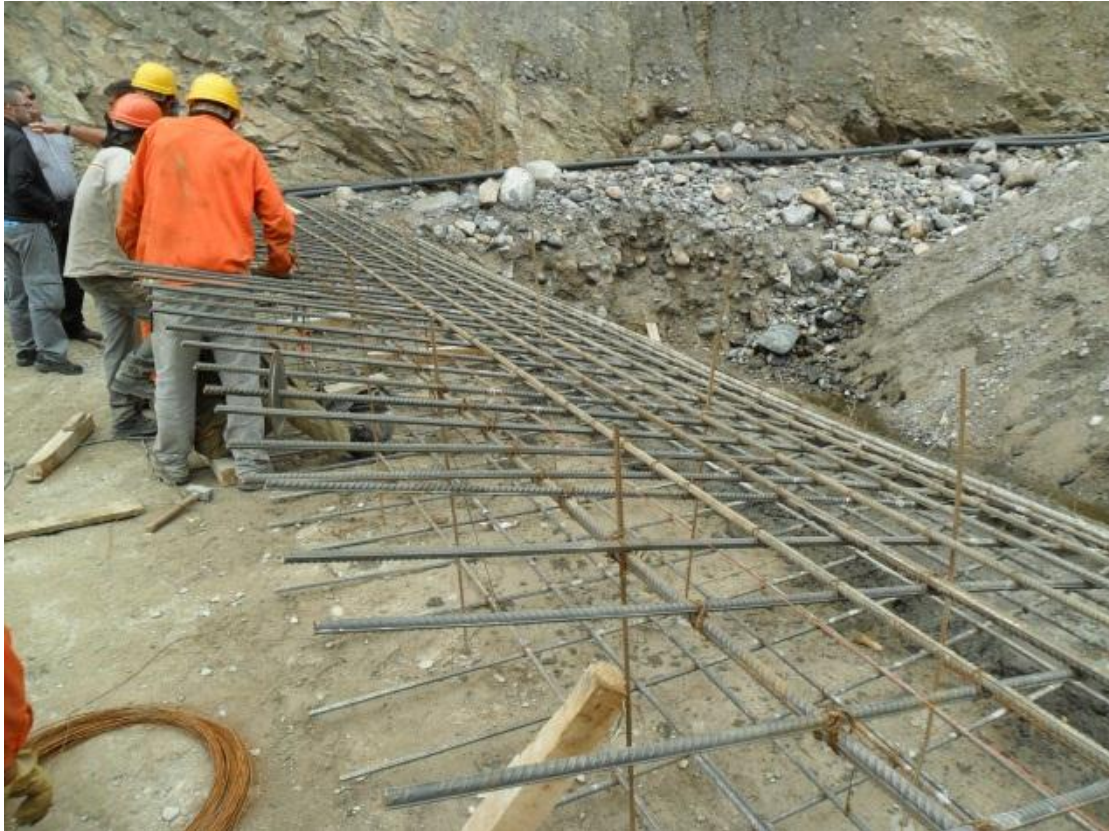
Imagen 18 - Armadura de Hierro para losa inferior desde la Pantalla hasta el Masizo
