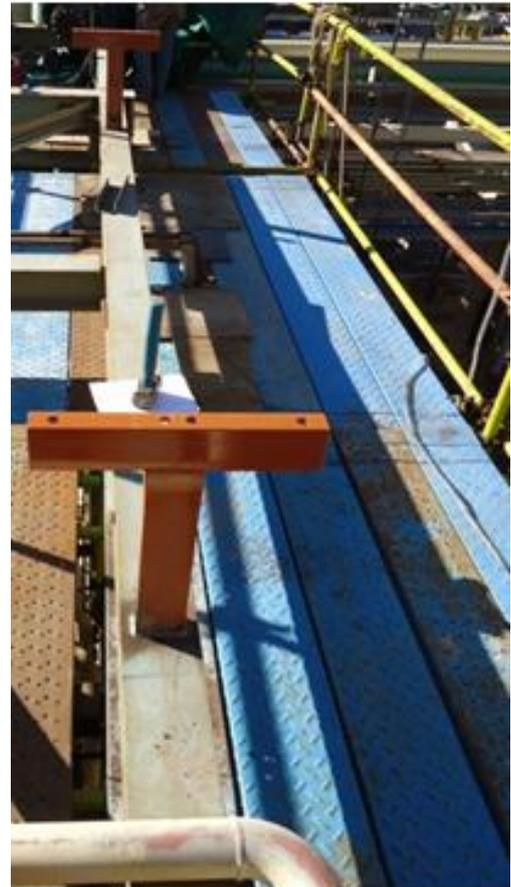
Figura 1 - 35 soportes colocados
