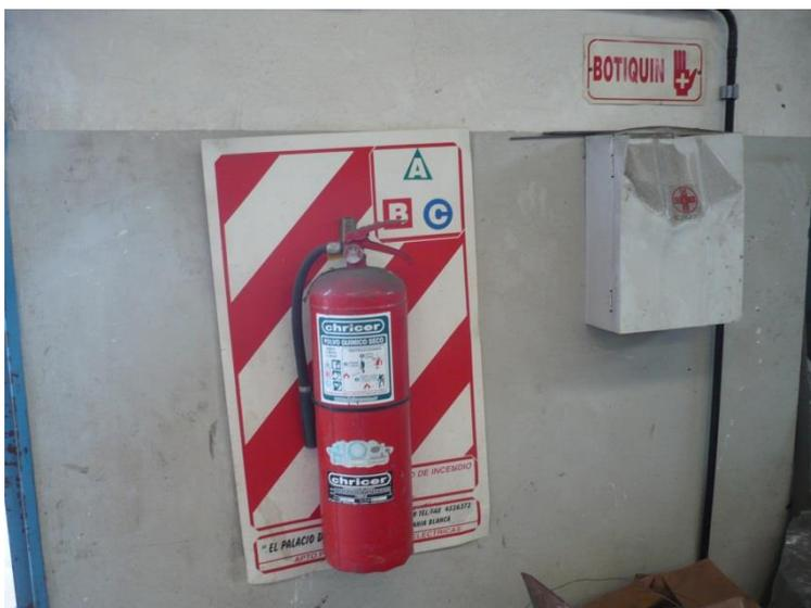
Fig. 2 – 9 Extintor con su adecuada señalización
