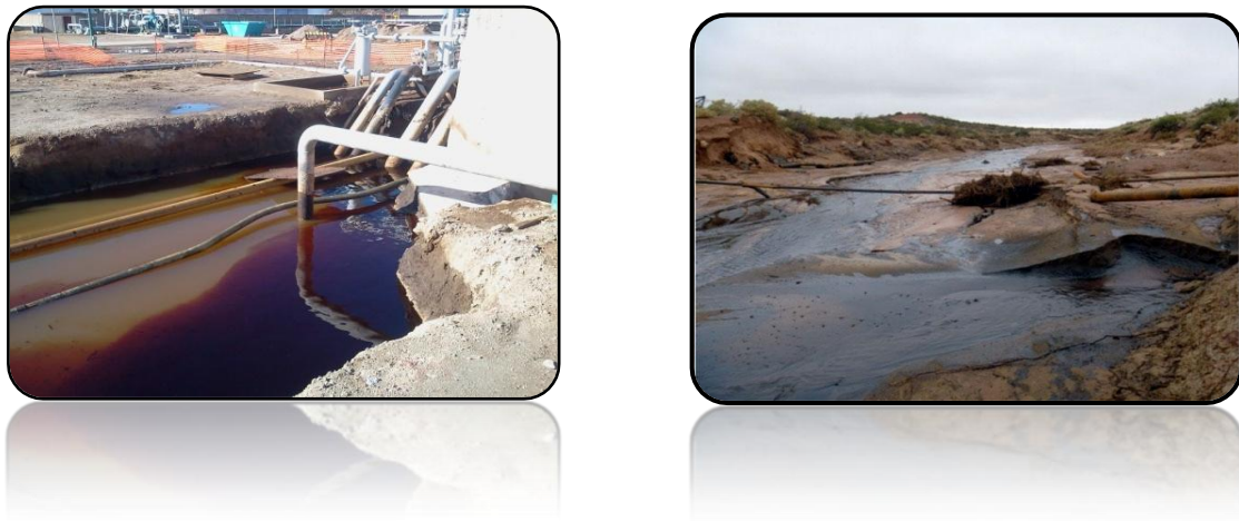
Figura 1. Ejemplos de nivel freático alto oleo contaminado.
