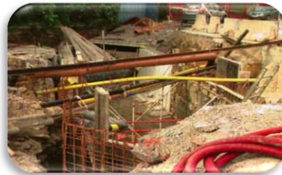
5.6.2.- Interferencias de conducciones subterráneas.
