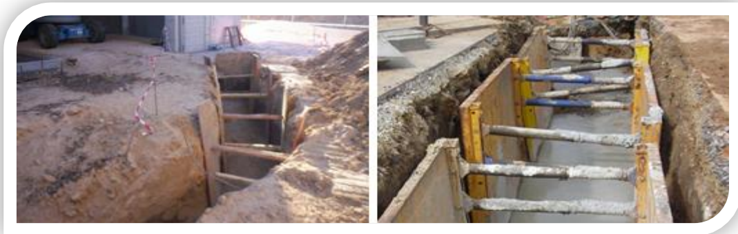
Figura 11. Entibado con maderas y entibado con placas metálicas.
