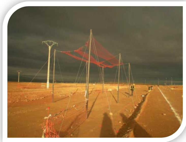
Figura 8. Tope de altura para pasar por debajo de líneas con tensión.
