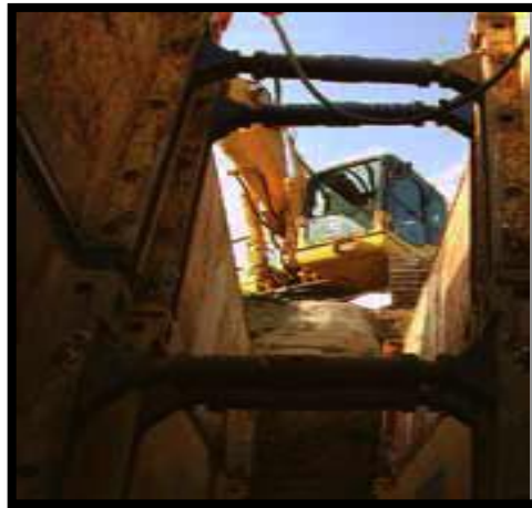
Figura 12. Entibado metálico con placas y travesaños.
