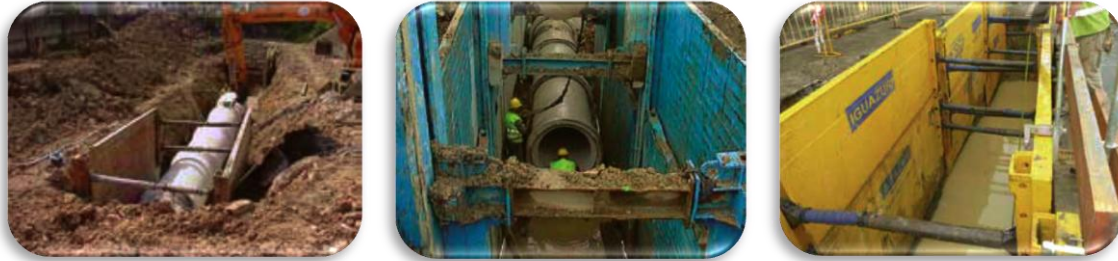
Figura 3 - Diferentes tipos de entibados.
