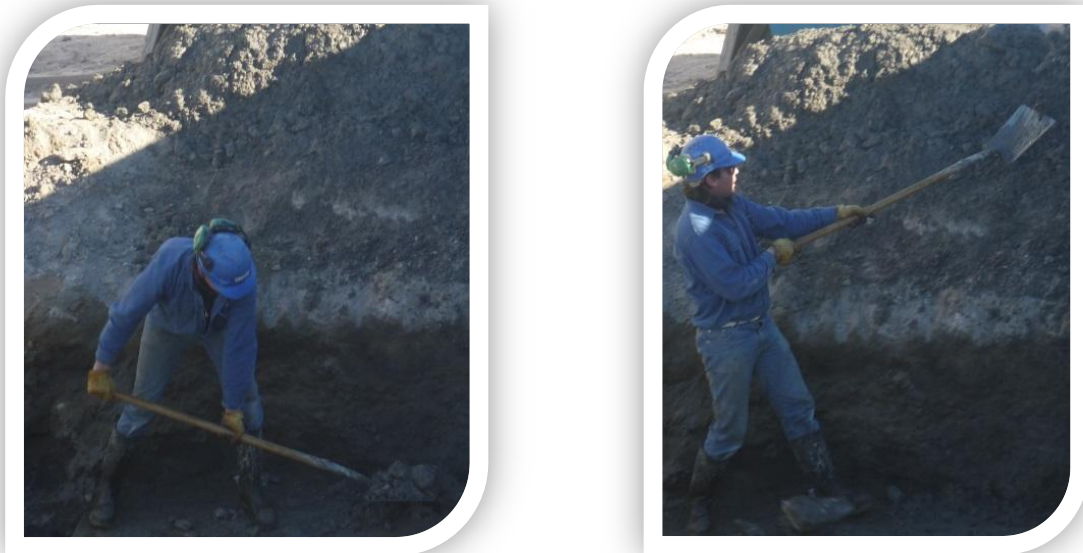
Figura N° 9. Operario desarrollando movimientos de excavacion.
