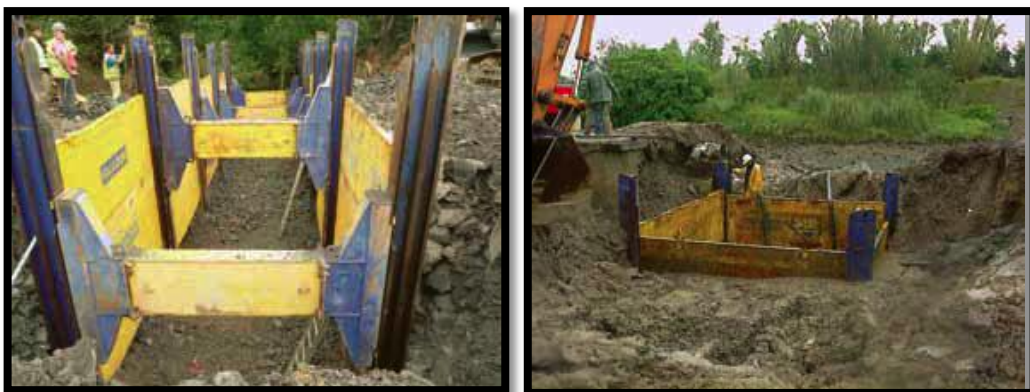
Figura 14. Entibación de excavaciones (zanja y cámara).
