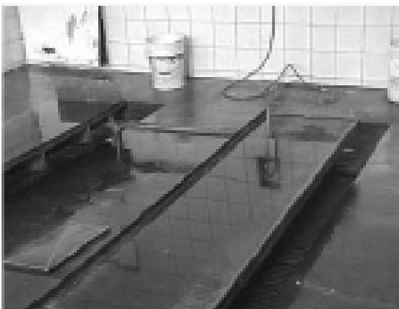
Las canaletas poseen una reja en su parte superior que permite el tránsito. Esta reja debe ser lo suficientemente fuerte como para permitir la circulación y estacionamiento de los vehículos pero debe estar diseñada de tal manera que su peso y tamaño no represente un problema para que los operarios puedan levantarla en forma segura y frecuente a los fines de proceder a la limpieza del cuenco de arenas.
