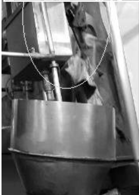
Puesto corta patas, tijera modelo 30CL-1 sin doble comando, se observa al operador de la herramienta utilizar solo una mano para accionar la tijera y con la otra mano toma la pata cortada para arrojarla al ducto que se ve debajo.
