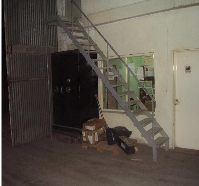
Escalera sin señalización.
