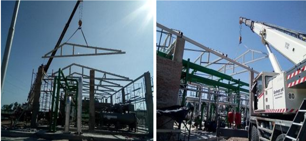
Izado y colocación de estructuras a dos Aguas desiguales
