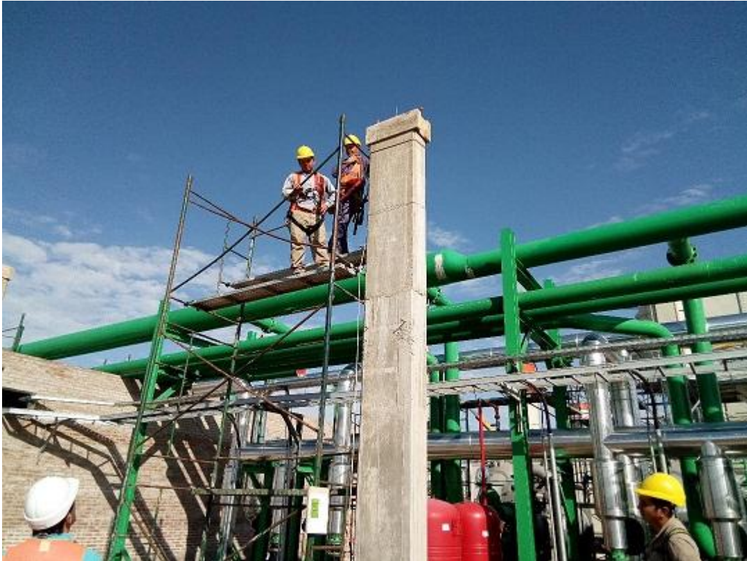
Colocación de bases de metal con método de Mortero (Grouting)
