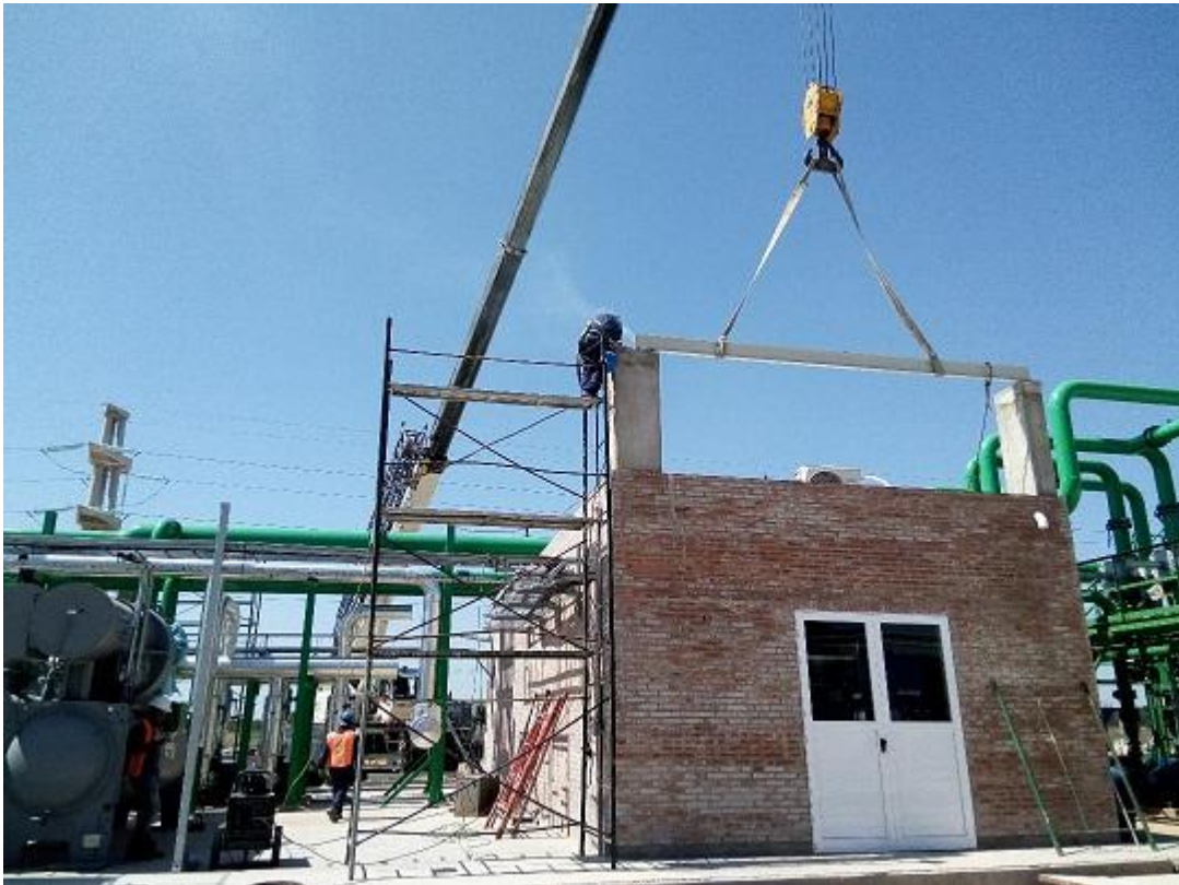
Colocación Hierro doble "T" sobre bases de metal dispuestas en las columnas de hormigón
