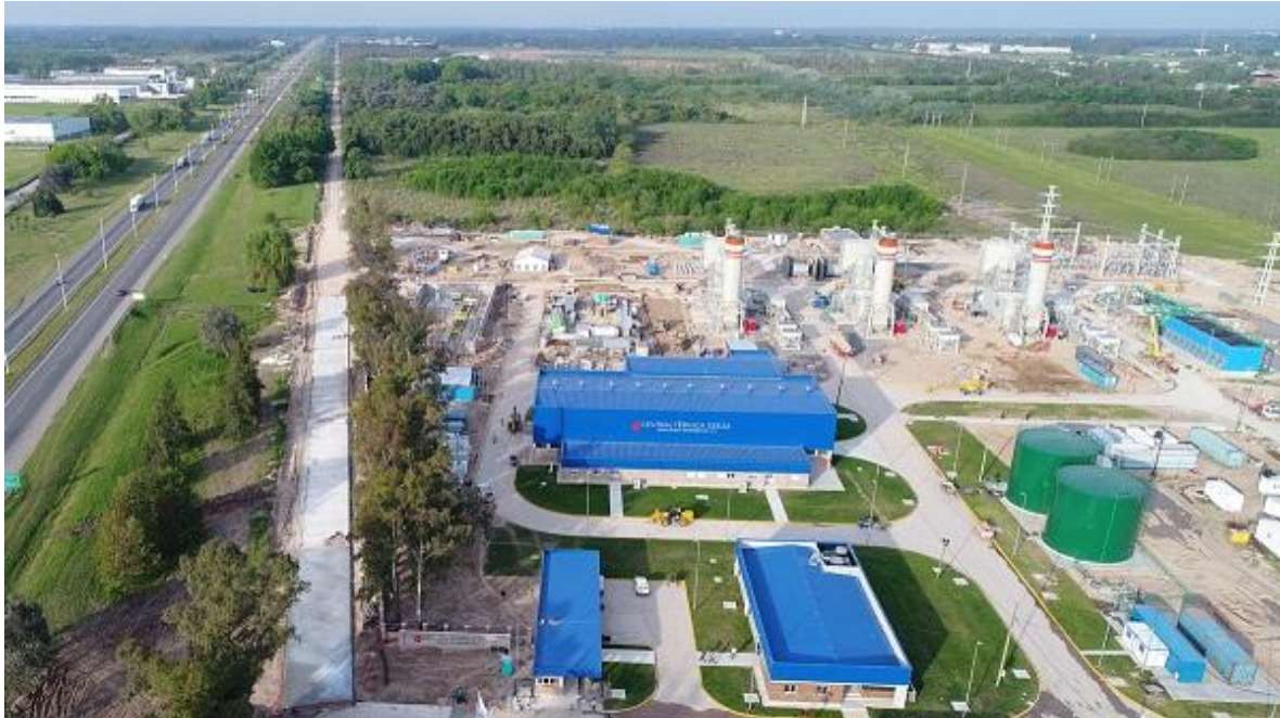
Vista Aérea Sur de la Central Térmica Ezeiza Frente
