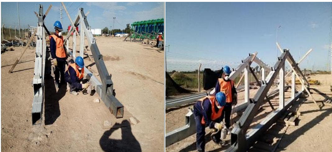
Acondicionamiento, Ajustes y pinturas de Estructuras
