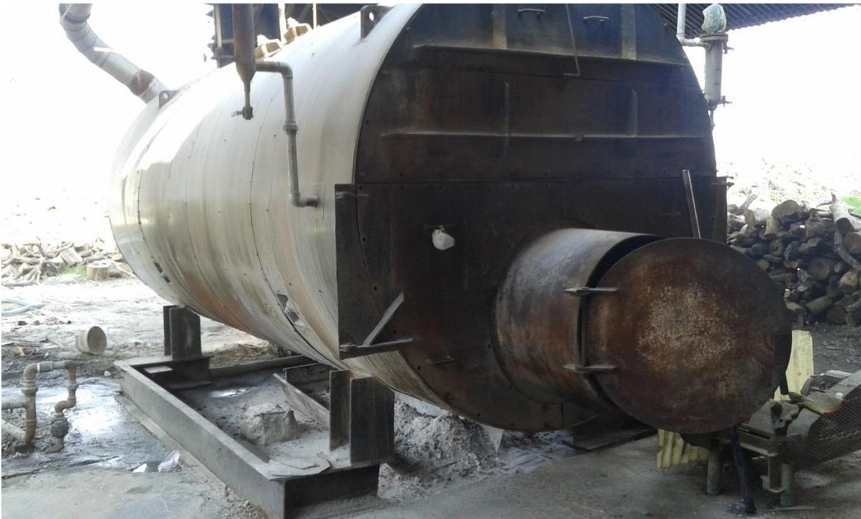
Una caldera básicamente es un recipiente de acero donde se quema un combustible y el calor generado en la reacción de combustión se transmite al agua líquida y se produce vapor de agua.
