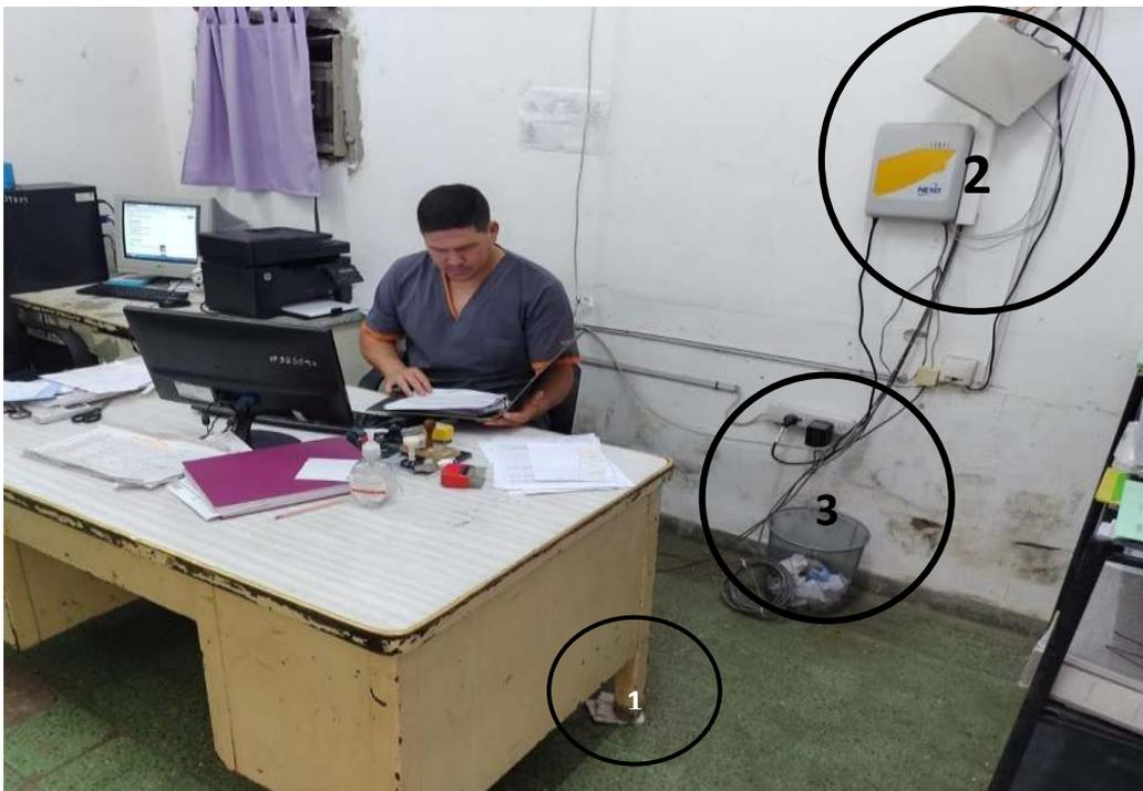
En la siguiente imagen se puede observar que en el puesto de trabajo tenemos el escritorio que está apoyado sobre un pedazo de cartón para darle cierto nivel y que el mismo no se mueva (1), se observa un rack de informática que esta abulonado a la pared y de él salen los cables para las computadoras y los teléfonos internos del servicio (2) y seguido se puede constatar que hay una zapatilla eléctrica donde se toma la
