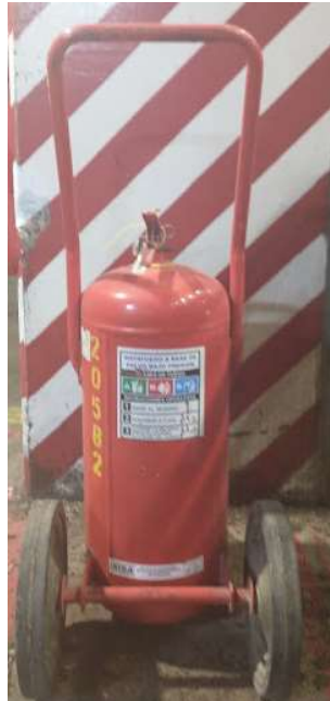
Foto 2.4 - Carro extintor PQS de 25 Kg
