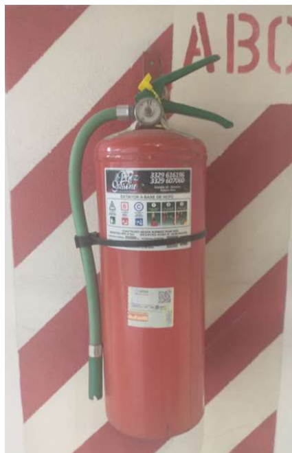
Foto 2.3 - Extintor HCFC-123 (Halogenado) de 5 Kg
