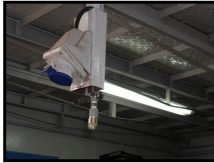
Figura 19 – Conexión a línea neumática.
