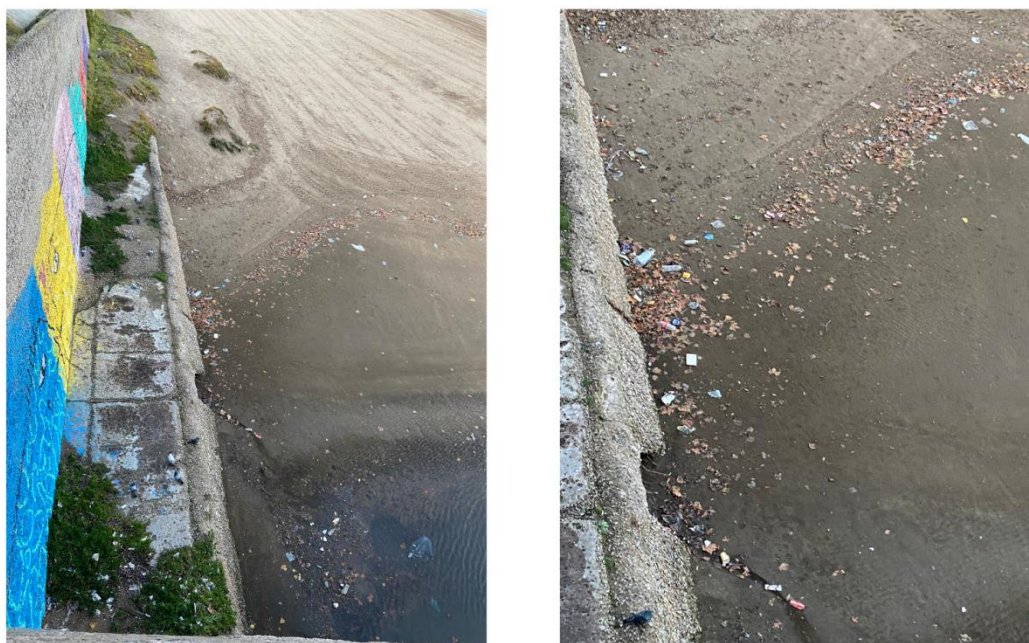
Figura 53: Desagüe pluvial Constitución y la costa, Mar del Plata.
