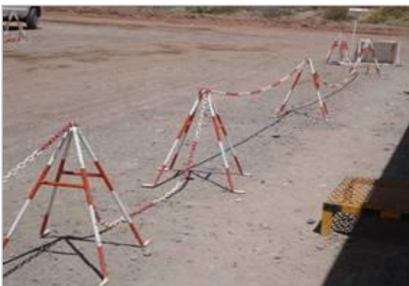
Foto 24 – Señalización de Limitación de zonas
