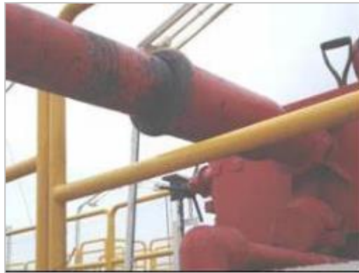
Foto 18 – Conexión de Unión Dresser
