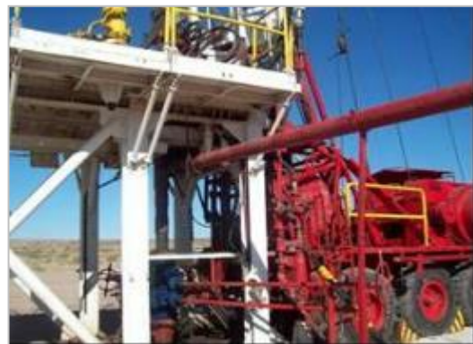
Foto 17 – Caño Lateral Instalado
