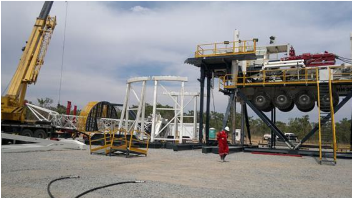
Foto 3- DTM- Acondicionamiento del equipo de Perforación
