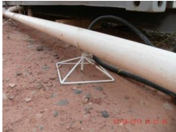
Foto 25- Reemplazo de estacas por base reguladora
