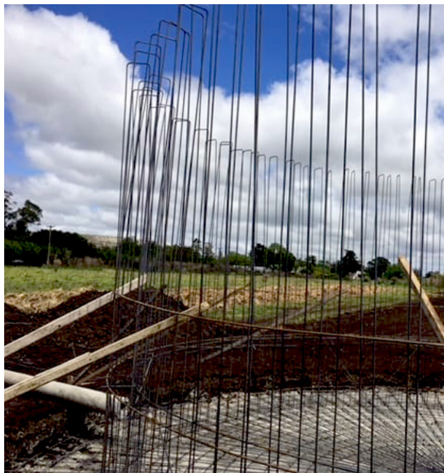
Figura 2. Fabricación de estructuras. Fuente: Argentina.gob.ar
