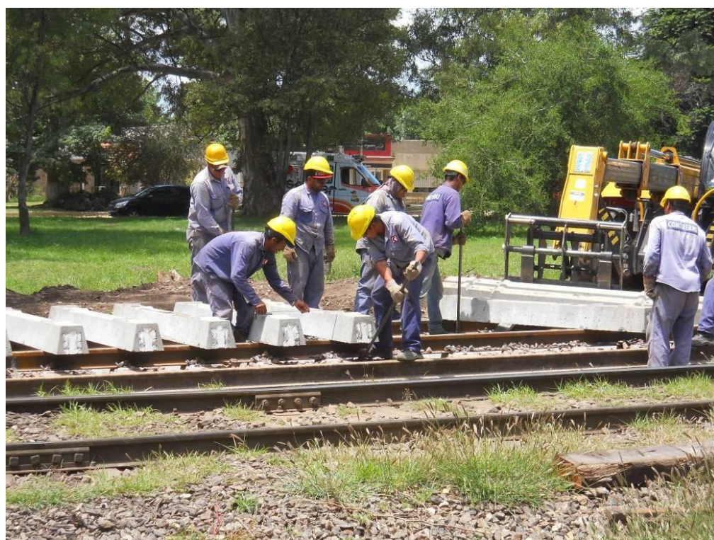
Fotografía N° 21 –Movimiento de durmientes con barretas
