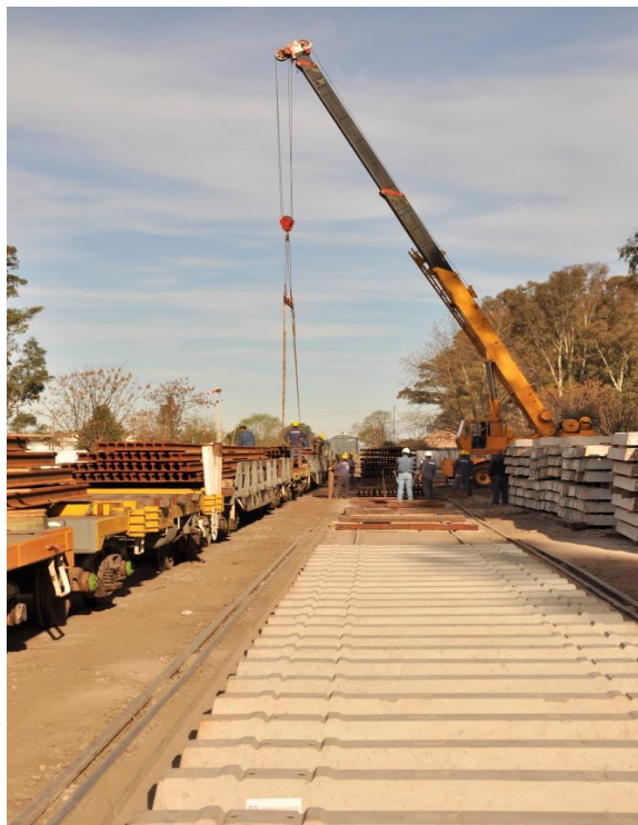
Fotografías N° 3 - 4 - Descarga de rieles por grúa
