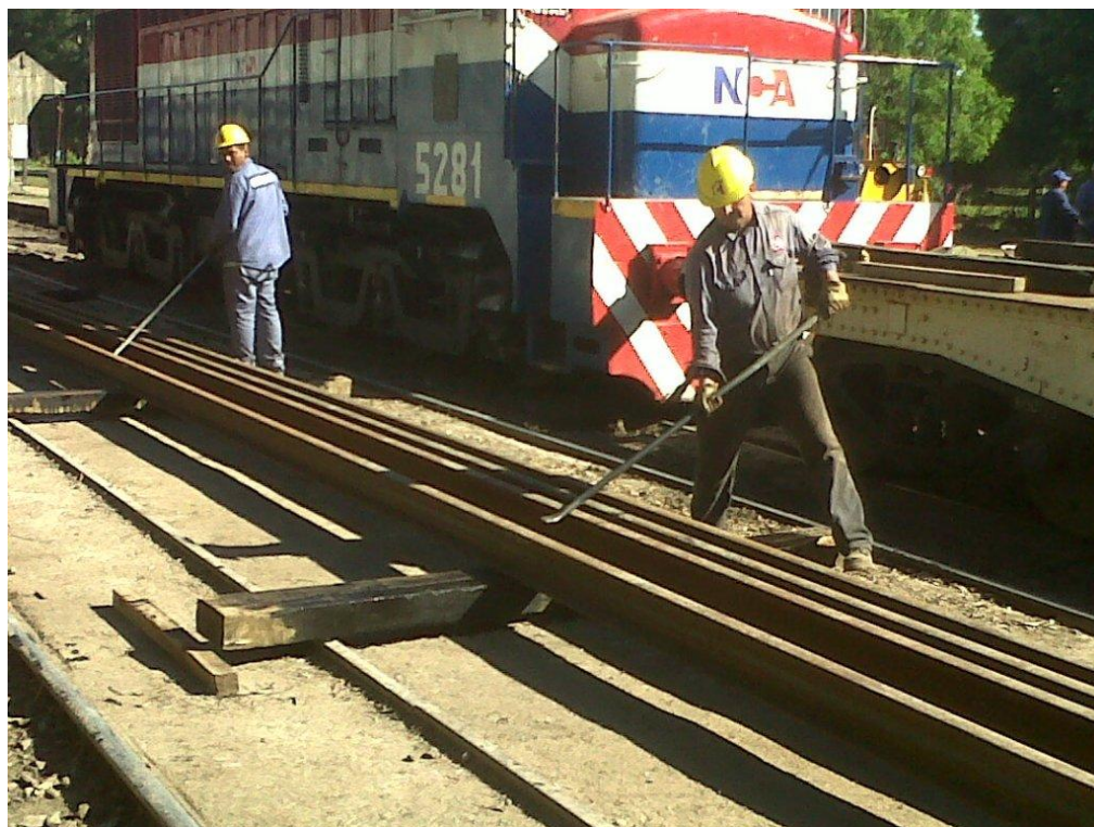
Fotografía N° 20 –Movimiento de rieles con barretas
