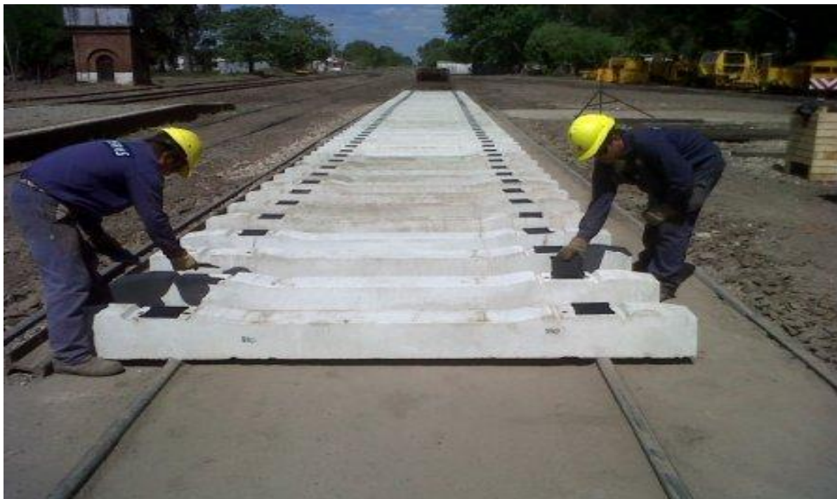
Fotografía N° 11 - Colocación de almohadilla
