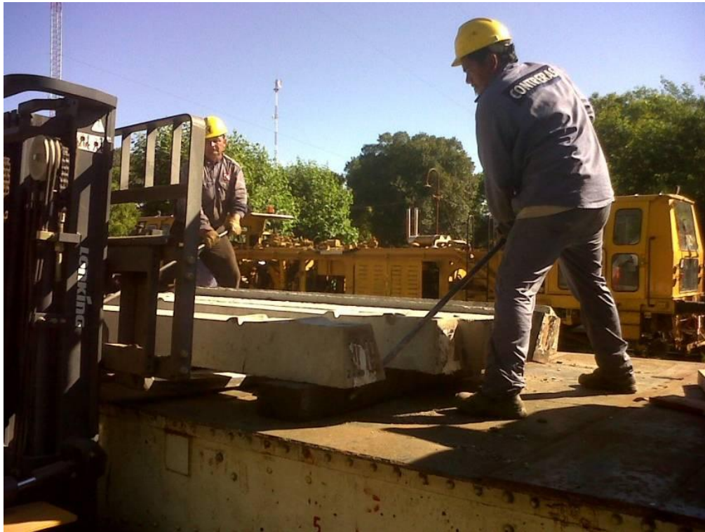
Fotografía N° 18 – Movimiento de durmientes con barreta
