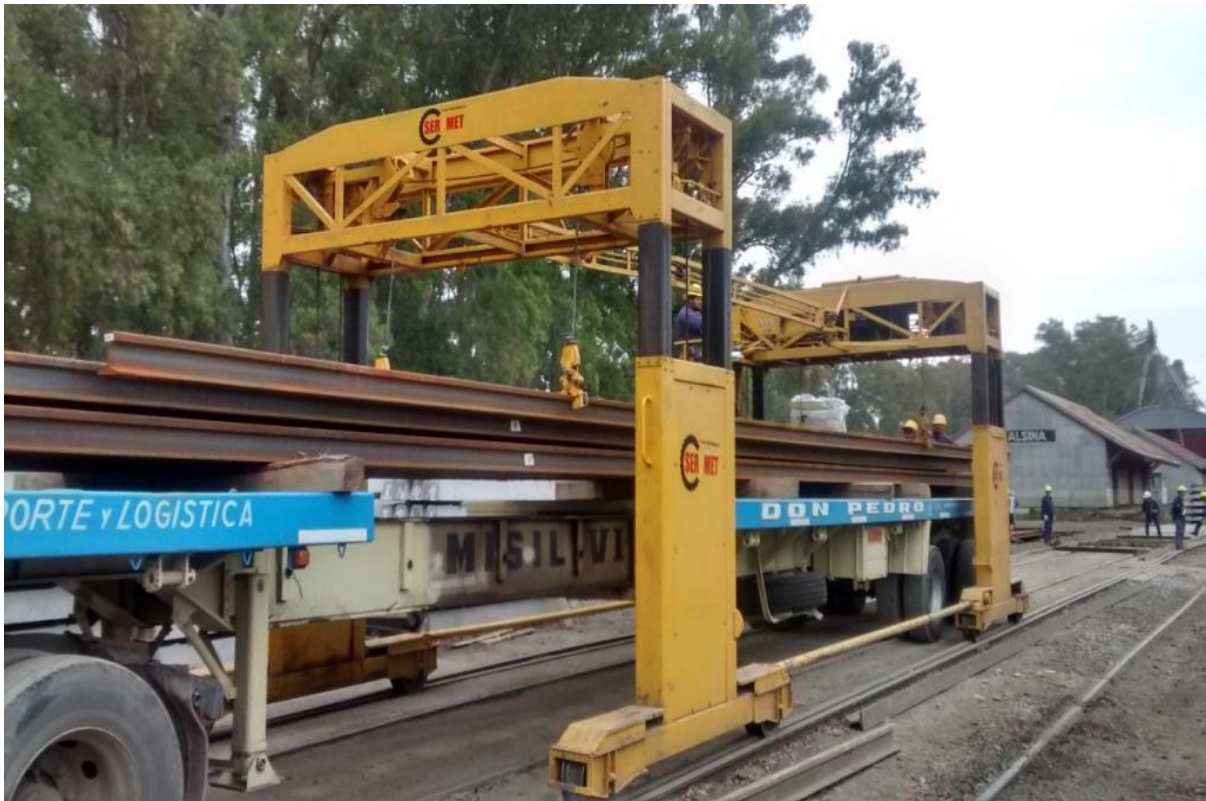
Fotografía N° 1 - Descarga de rieles por pórticos
