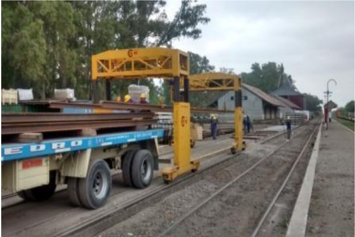
Fotografía N° 2 - Descarga de rieles por pórticos
