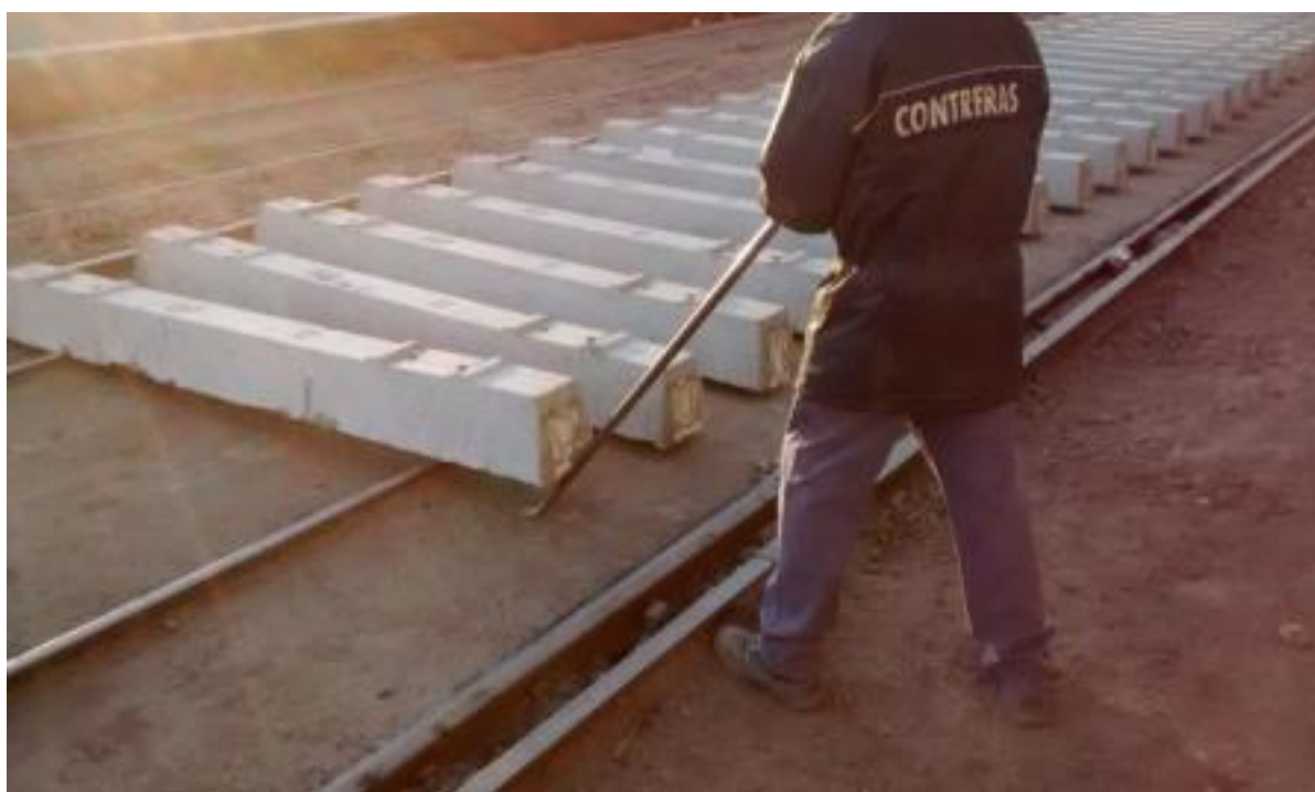
Fotografía N° 10 - Operario en tarea de alineación
