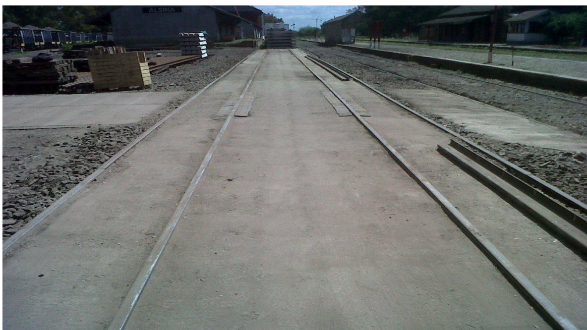
Fotografía N° 7 - Platea de Hormigón
