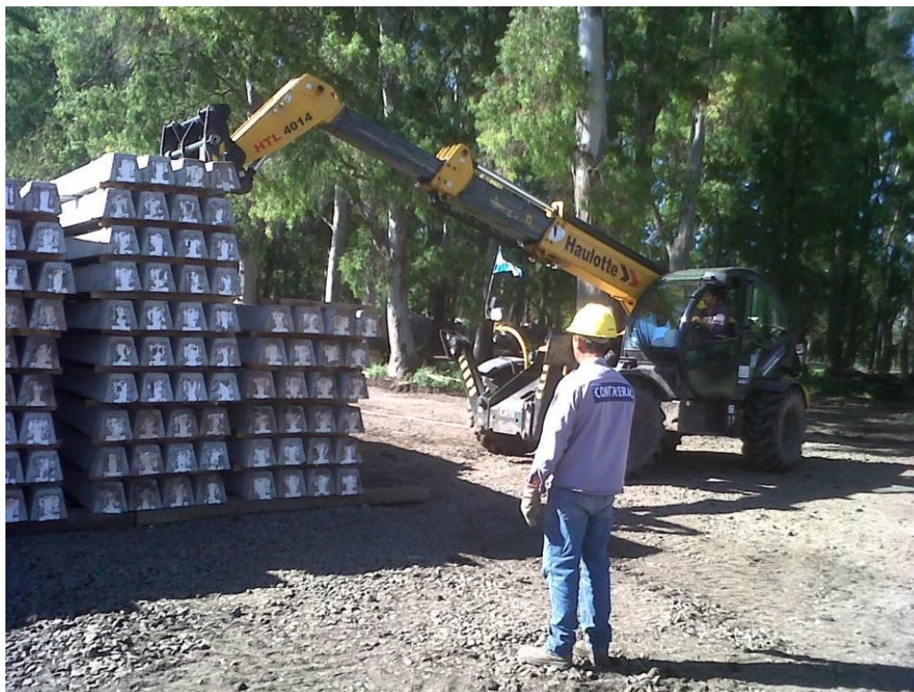
Fotografía N° 25 – Manipulador realizando tarea de acopio de materiales
