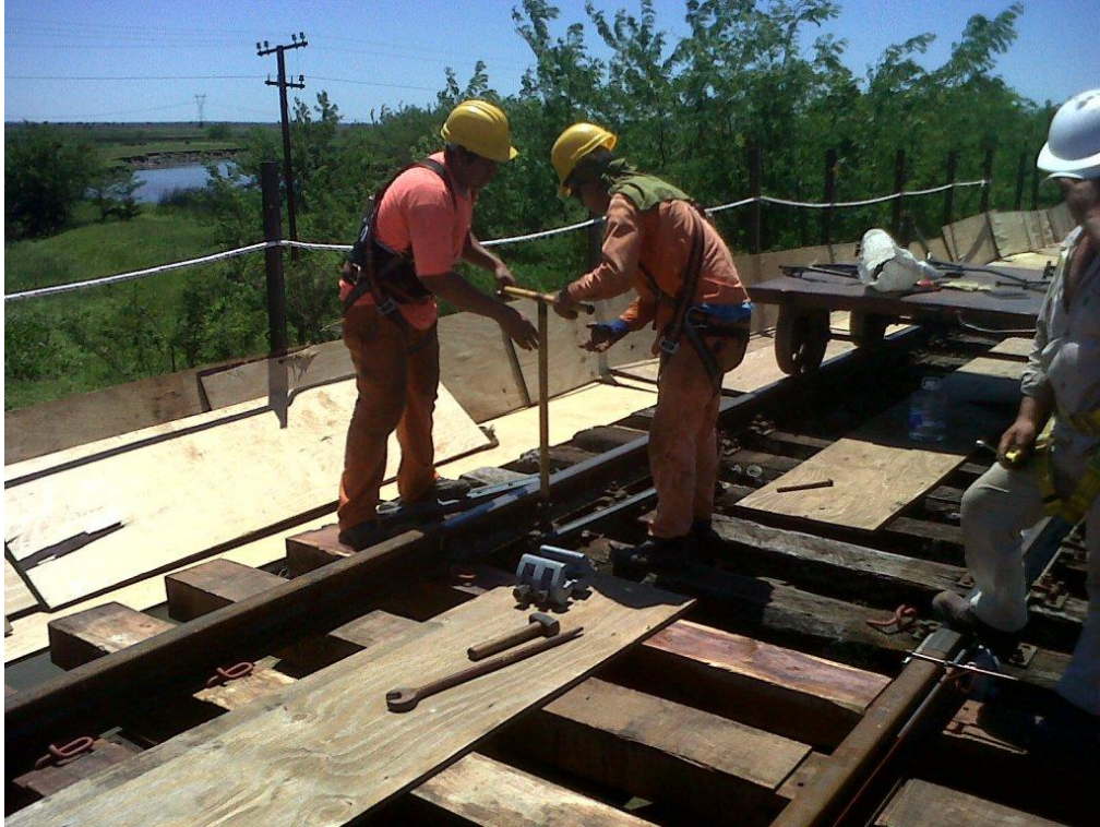
Fotografía N° 19 – Ajuste de tirafondo con llave T
