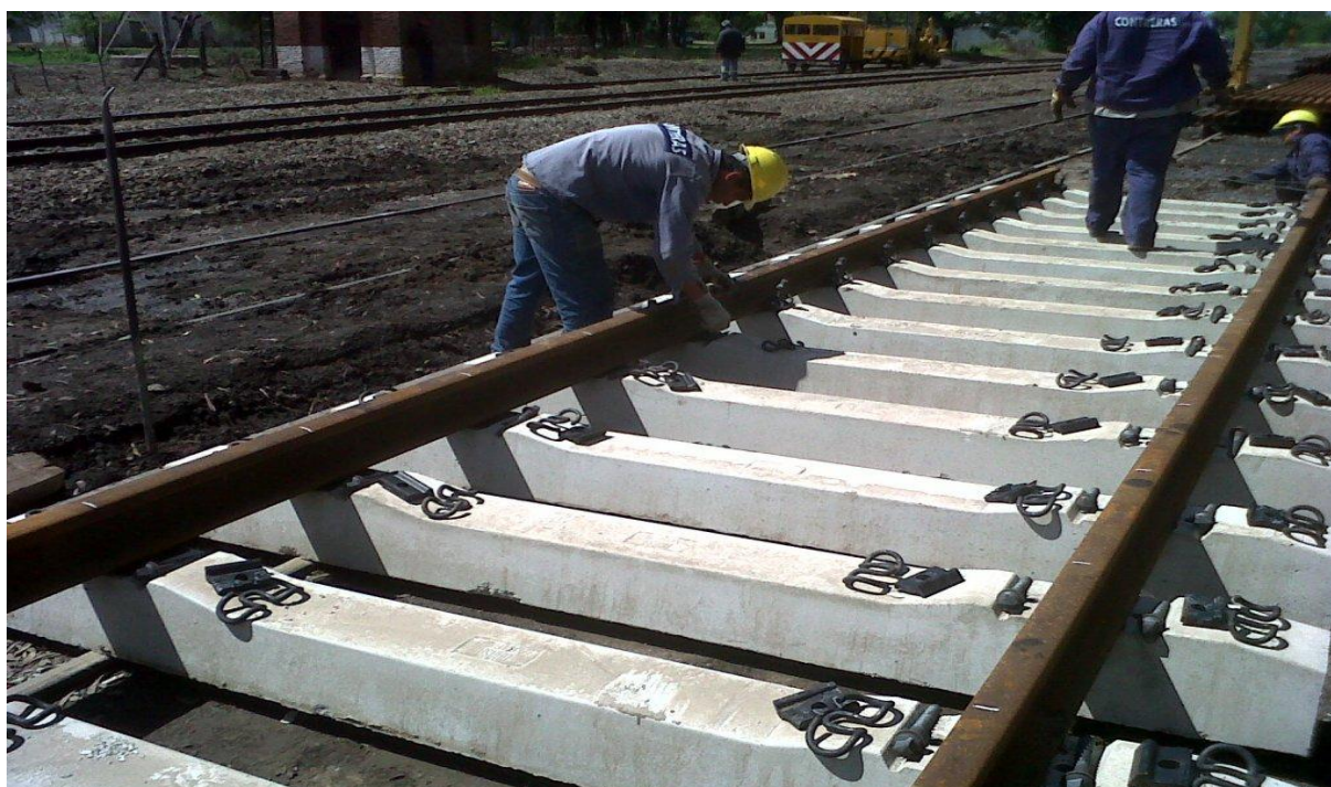
Fotografía N° 13 - Colocación de placas guías, clips elásticos y presentación de tirafondos
