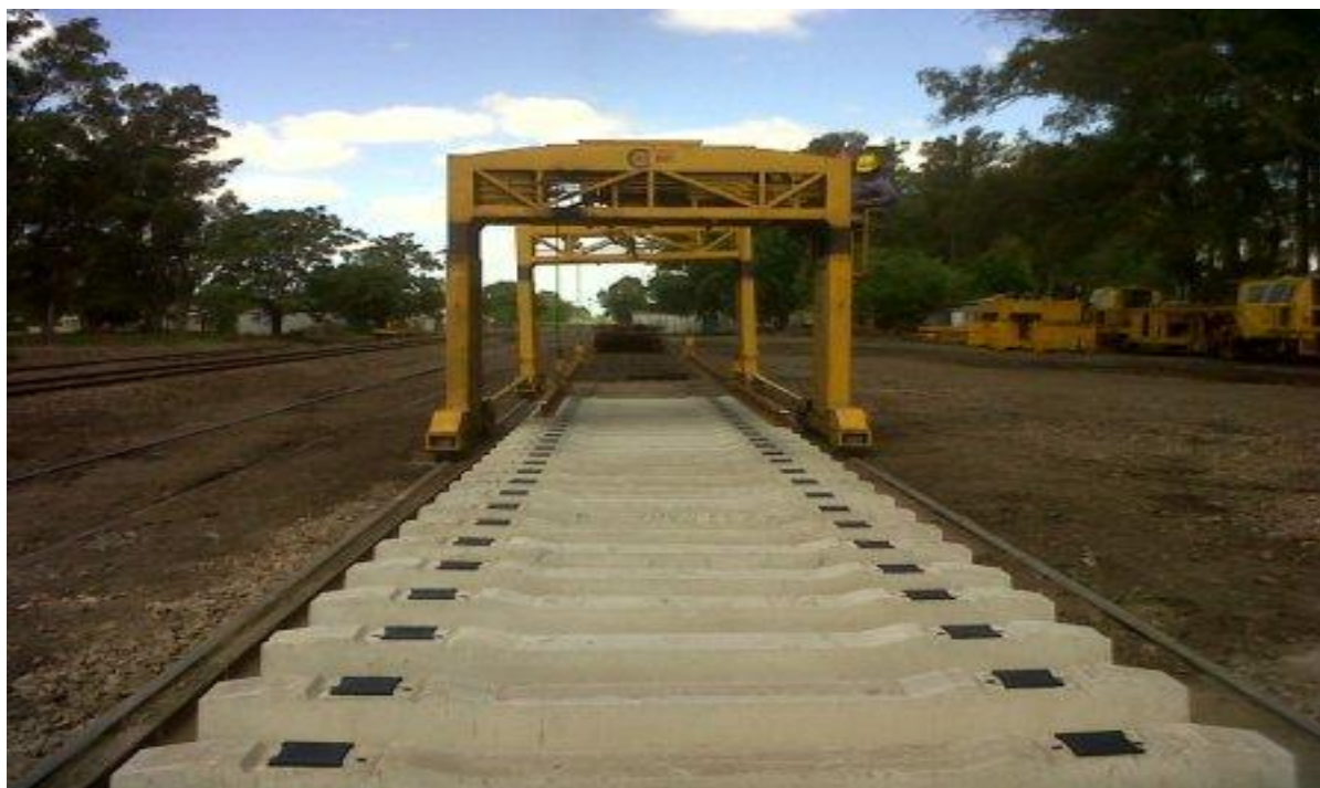
Fotografía N° 12 - Montaje de riel sobre almohadilla
