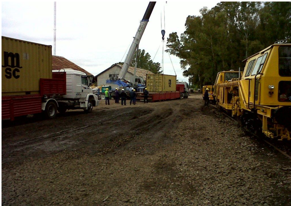
Fotografía N° 27 – Tarea de descarga de contenedor con grúa
