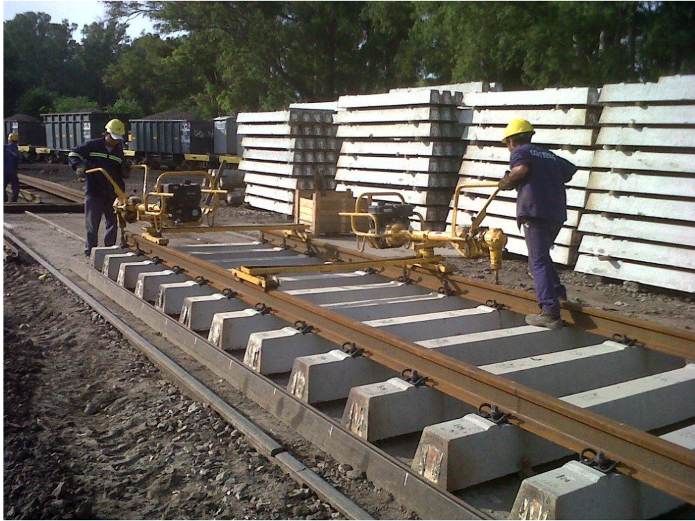
Fotografía N° 22 –Ajuste de tirafondos con tirafondeadoras
