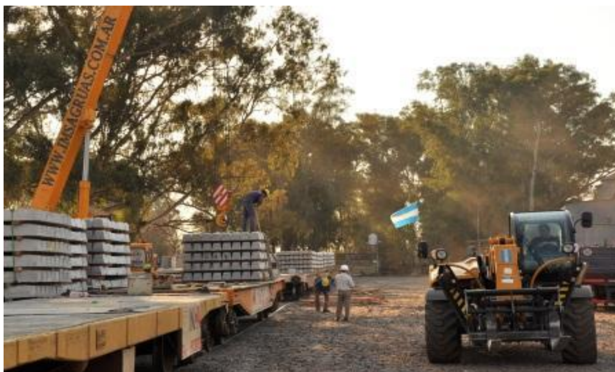
Fotografías N° 5 - Descarga de durmientes
