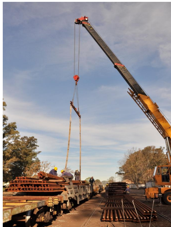
Fotografías N° 3 - 4 - Descarga de rieles por grúa
