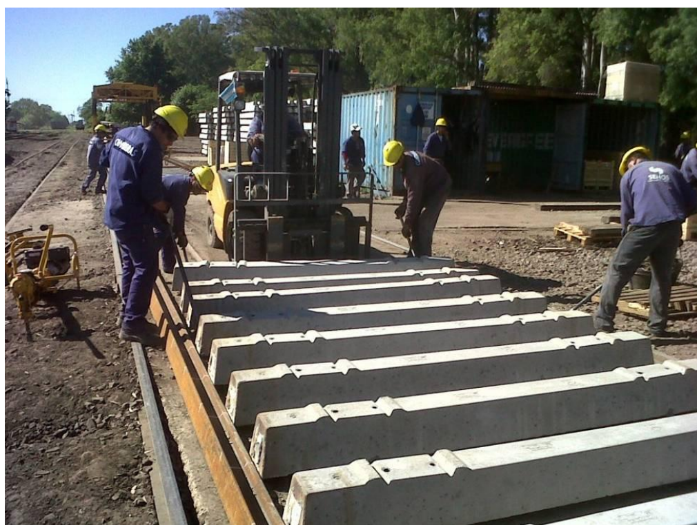
Fotografía N° 26 – Distribución de durmientes por autoelevador
