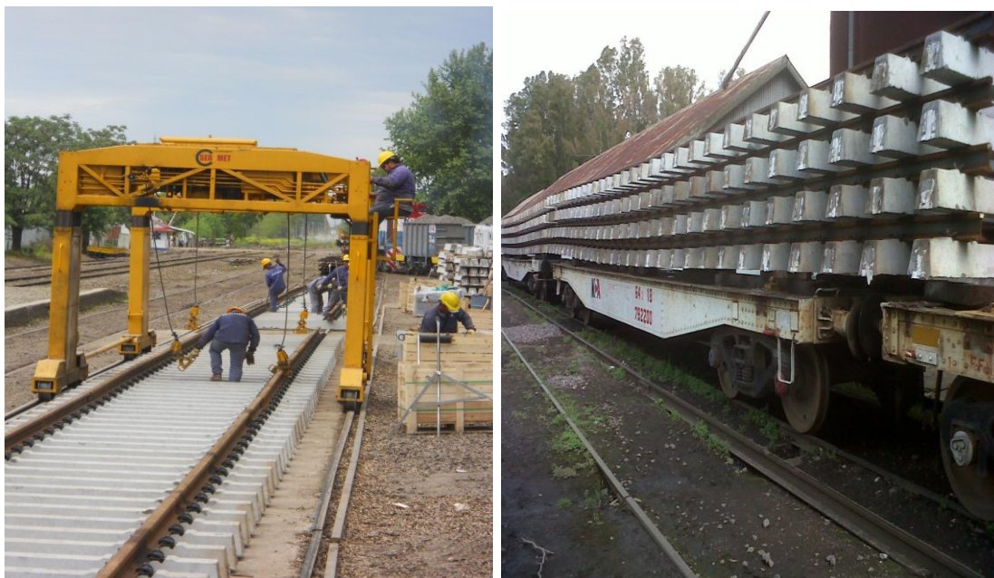
Fotograf as N  16 y 17 – Enganche de tramos con p rtico y acopio de tramos sobre vagones playos
