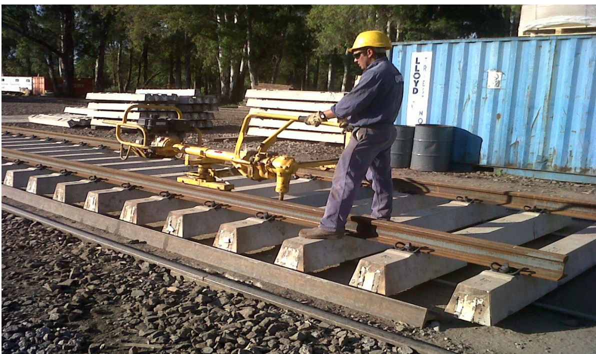
Fotografía N° 15 - La tirafondadora se desliza sobre un carro el cual permite mover el equipo a cualquiera de los rieles
