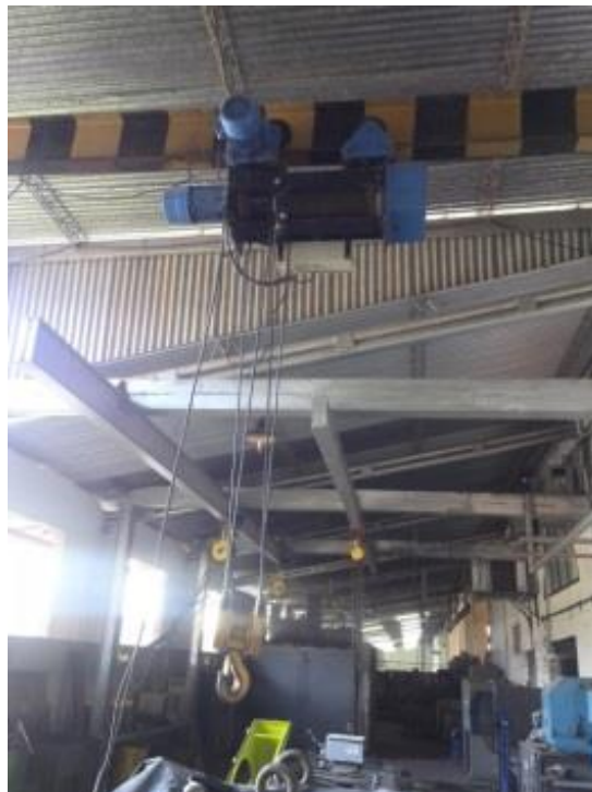
Imagen del aparejo eléctrico nuevo
