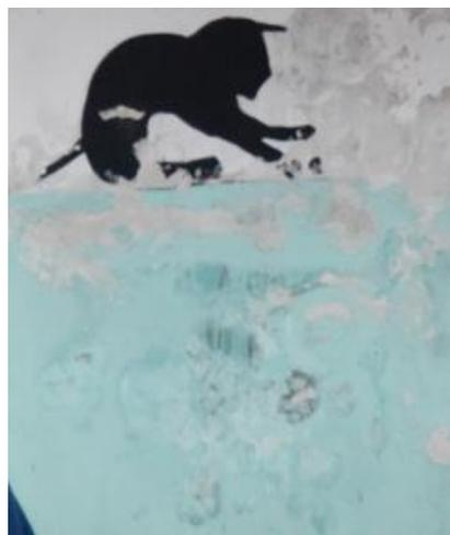
Imagen 7.6. Efecto de la humedad en las paredes de las aulas. Fuente: Elaboración propia.
