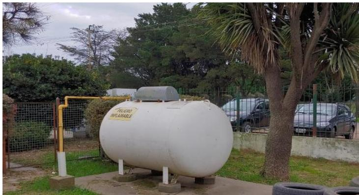
Imagen 7.11. Tanque de almacenamiento de gas propano. Fuente: Elaboración propia.
