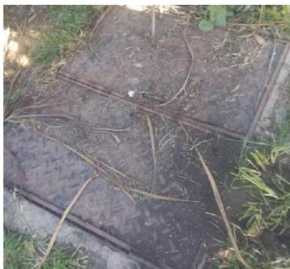
*Imagen 7.17. Tapa de la cámara séptica. Fuente: Elaboración propia.*
