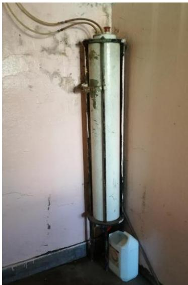
*Imagen 7.16. Filtro de purificación del agua. Fuente: Elaboración propia.*
