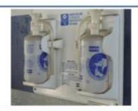
Desvío detectado: Lavaojos en mal estado de limpieza y sin control evidente de estado de liquido
