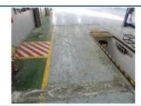
Desvio detectado: Sendas de circulación en mal estado piso deteriorado puede provocar riesgo de caída
