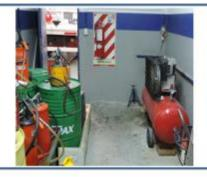
Desvío detectado: Compresor de aire ubicado en recinto de acopio de aceites grasas y otros combustibles Acción correctiva propuesta: Retirar el compresor del
