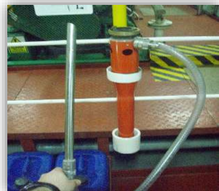
Foto 59: Lanza para suministrar espuma, extintor portátil de sala de máquinas. Fuente, elaboración propia
