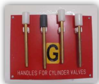
Foto 52: disparo manual de batería de tubos de CO 2 . Fuente, elaboración propia.
