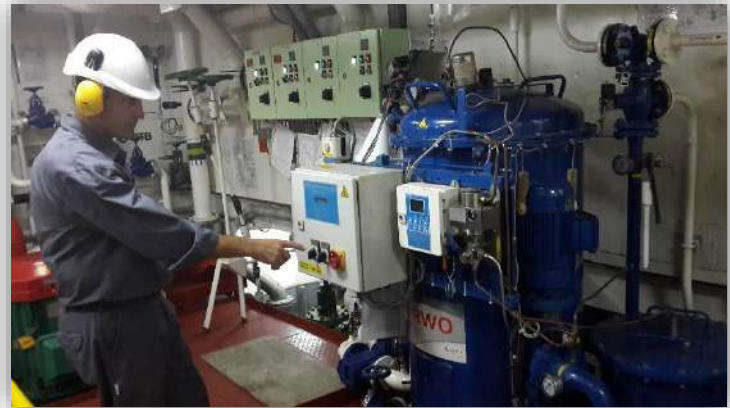
Foto 25: se ponen en marcha la casi totalidad de los equipos que generan ruido, servicios de agua potable o de desechos cloacales al momento de medir ruidos. Fuente: elaboración propia
