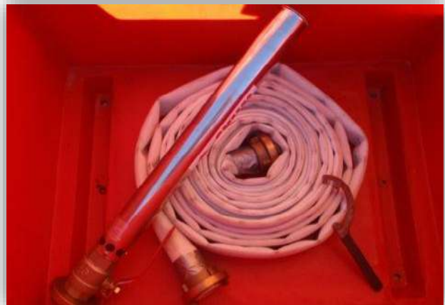
Foto 47: Lanza con manguera para espuma. Fuente, elaboración propia.
