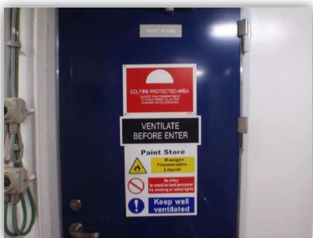
Foto 38: Clara identificación de un espacio con riesgo de acumulación de gases explosivos, como lo es el cuarto de pinturas. Es protegido por un sistema extintor de CO2. Fuente, elaboración propia.
