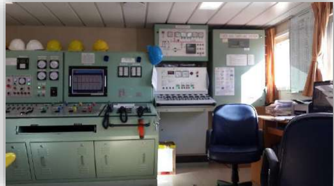
Foto 32: Cuarto de carga de buque tanque petrolero actual, a derecha monitor de gases explosivos, en tanques de lastre. Fuente, elaboración propia.
