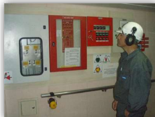
Foto 17: en el momento de la recolección de datos es importante observar instalaciones, equipos y sistemas de seguridad. Fuente, elaboración propia.
