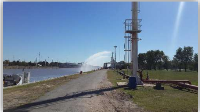
Foto 35: Prueba de monitores a distancia, Toma de amarre de Buques Tanque en Puerto La Plata. Fuente, elaboración propia.
