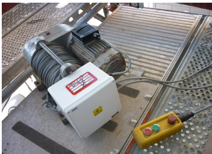
Foto 2. Malacate utilizado para tender los conductores eléctricos
