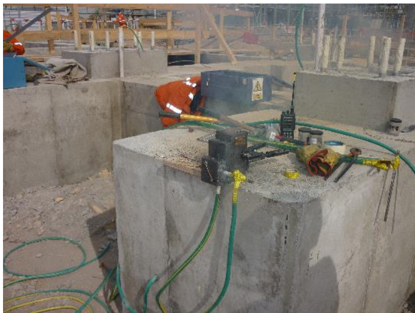
Foto 14. Momento donde se efectúa la soldadura.
