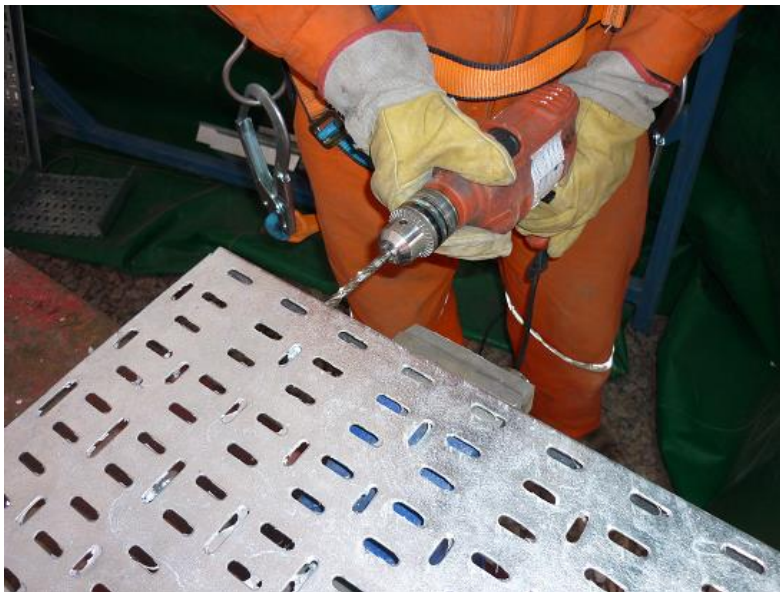
Foto 5. Momento en donde se realizan los nuevos orificios.
