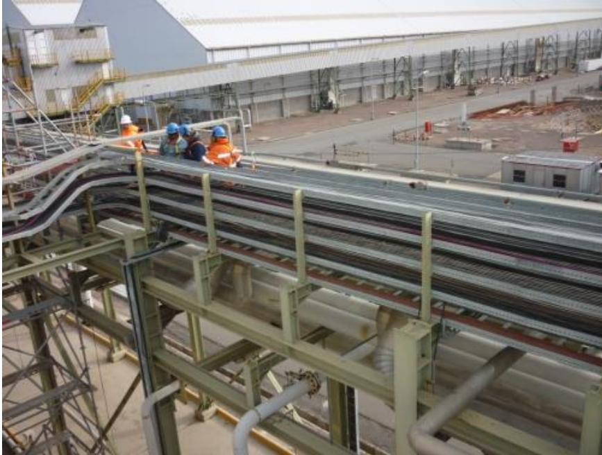
Foto 15. Trabajo en altura, sobre parral electrico existente.
