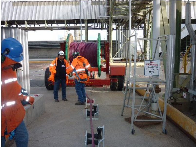
Foto 9. Ubicación de bobina y rodillos para tendido de conductores eléctricos.
