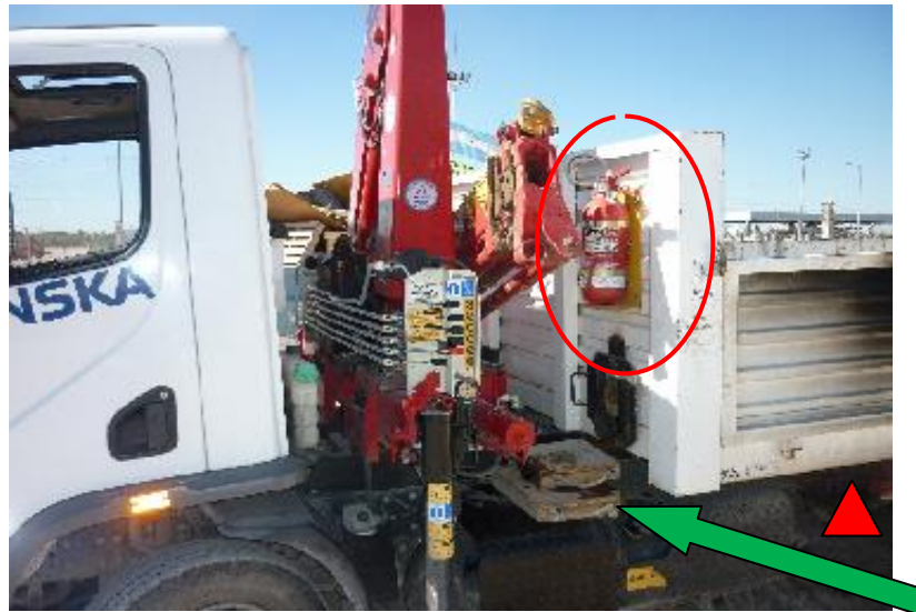
Foto 1. Hidrogrua utilizada para movilización de materiales y herramientas
