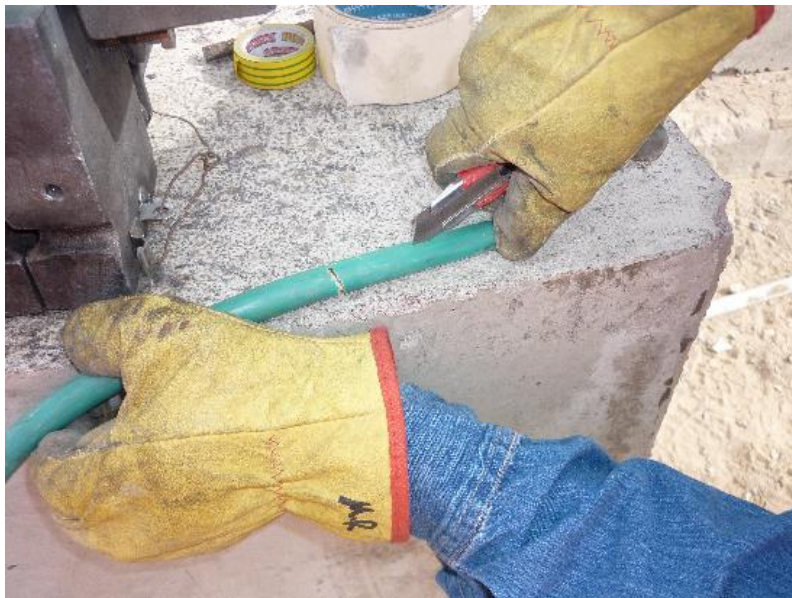
Foto 11. Momento de corte de aislación.
