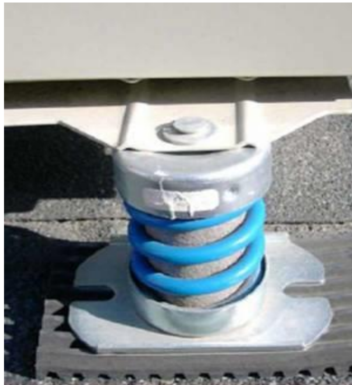
Figura 1. Amortiguador de ruido en la fuente generadora.
