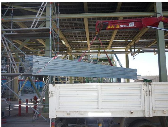
Foto 1. Maniobras de izaje de bandejas/materiales.
