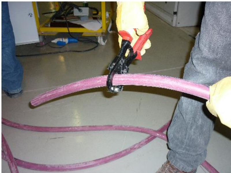
Foto 12. Instante de seccionamiento de conductor eléctrico.
