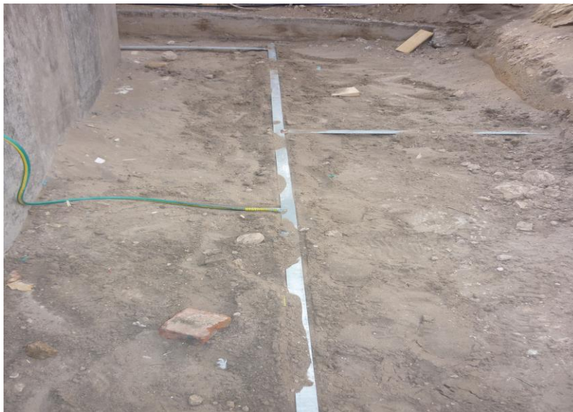
Foto 13. Vinculación de cable a malla de puesta a tierra.
