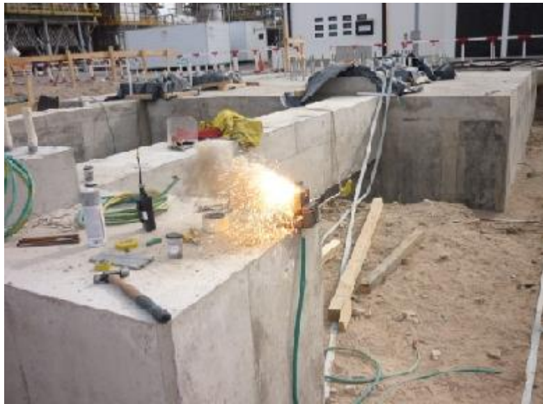
Foto 3. Instante donde se produce la fusión exotérmica
