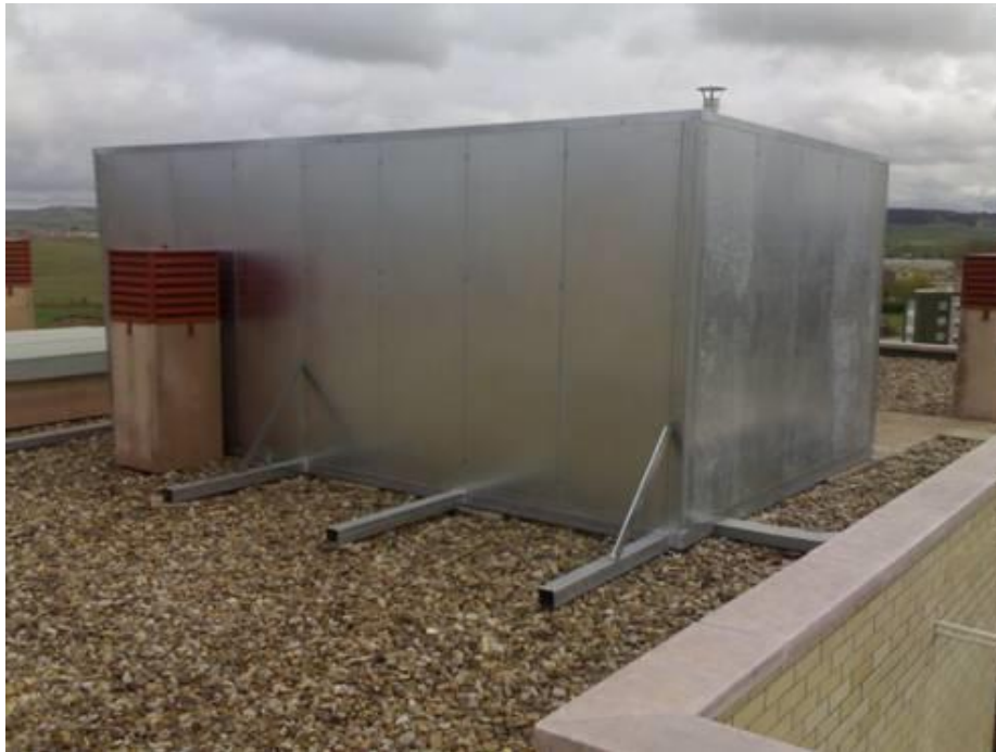
Figura 2. Paneles absorbentes, actuando como barrera del ruido.
