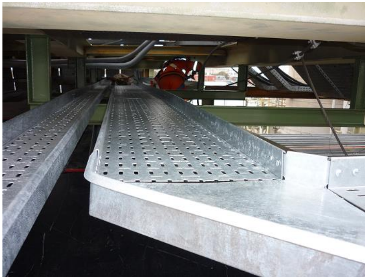
Foto 7. Colocación de bandejas sobre soportes.
