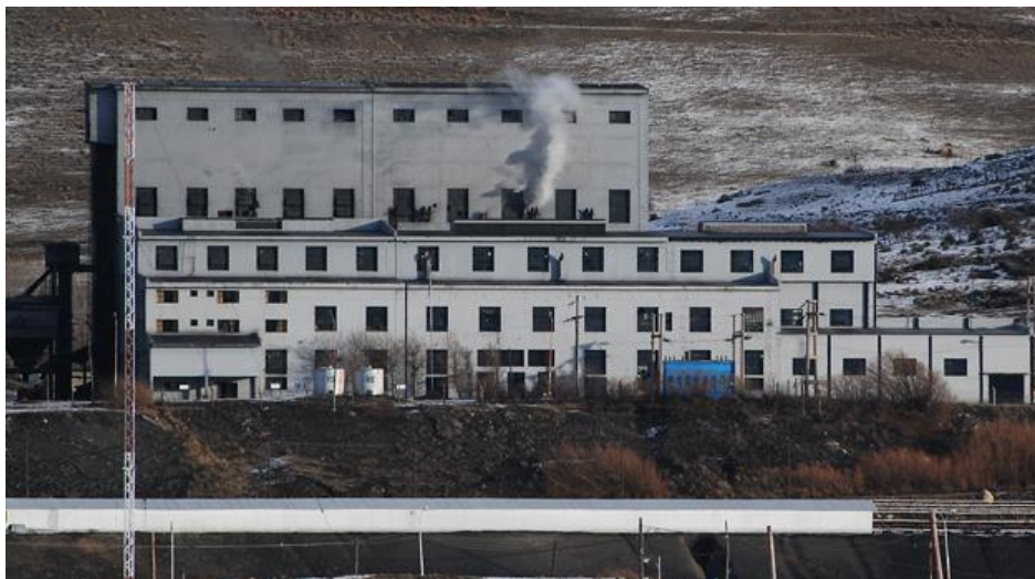
Usina Termoeléctrica 16 Mw
