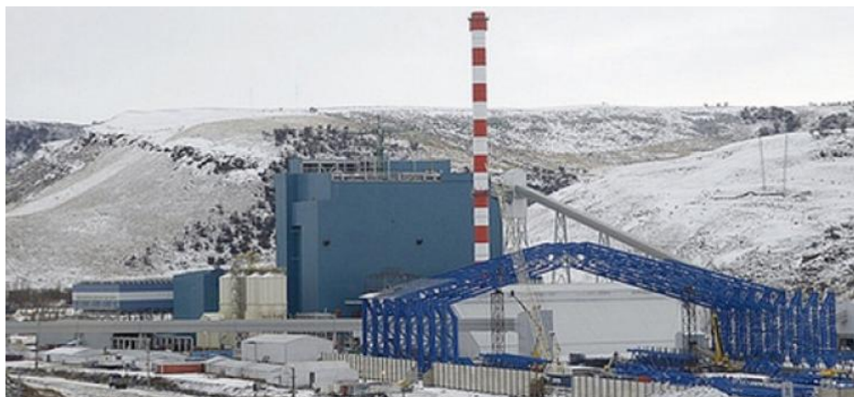
Usina Termoeléctrica 240 Mw en construcción
