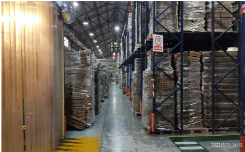
Imagen 3.2 Sector de incendio 1 (Nave 2)
