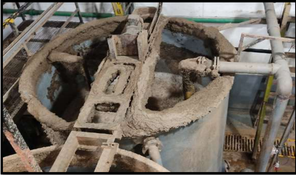
Imagen 1.16 Decantación y filtración (recipiente N°1).
