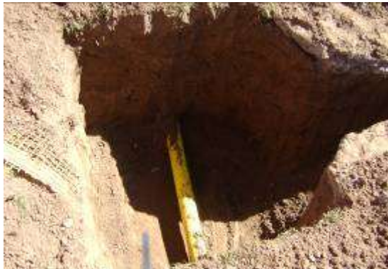
Pozo poco profundo Pozo sin escalón de ingreso/egreso
