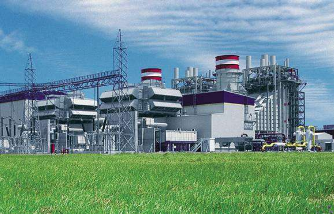
Usina generadora de ciclo combinado Gas Natural Fuel oil. FIG. 11.5
