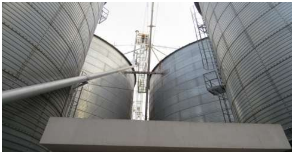
Imagen 2.5 Silos de almacenamiento de cereal
