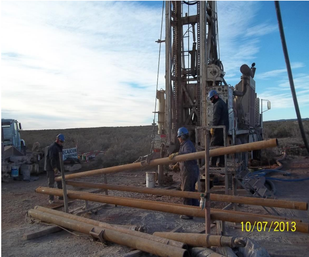
Figura: operarios en maniobra izando barra para agregarle a la columna de perforación en máquina perforadora.
