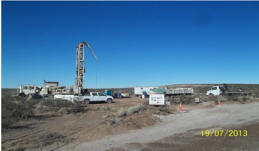
Figura: Locación Neuquén equipo perforador, obrador y equipos para la perforación de pozo freático.
