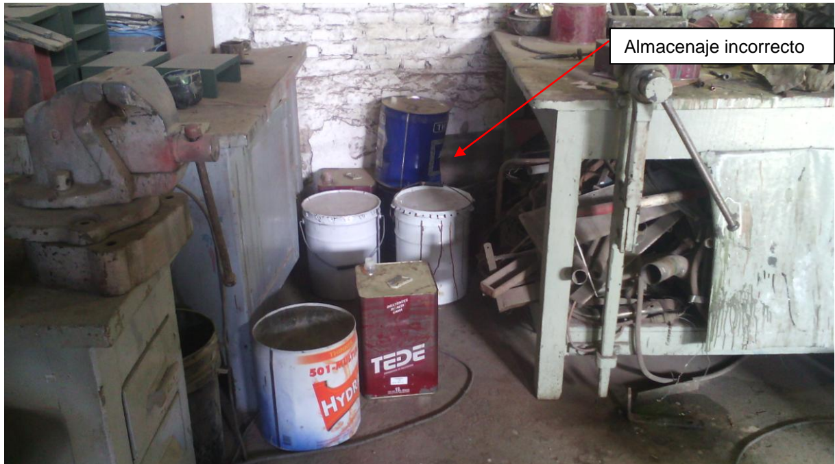
Figura 2.8: Almacenamiento incorrecto de solventes
