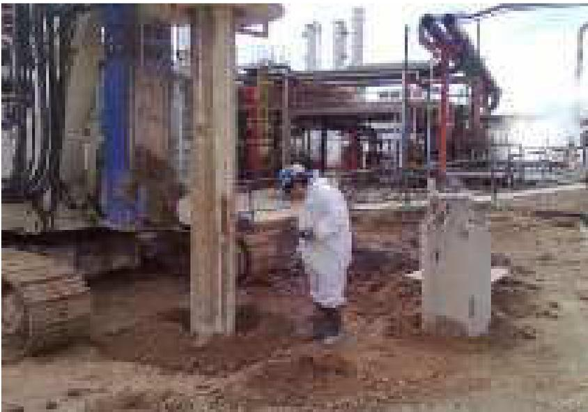
Figura N°4 Hoyadora operando en sentido vertical y centrado según las mediciones arrojadas por el estudio topográfico.
