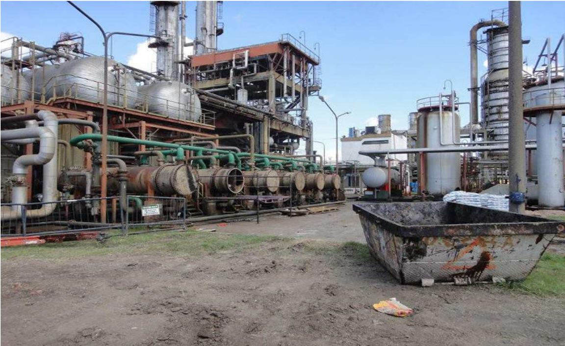
Figura N° 27 Volquete para el desecho de tierra contaminada.
