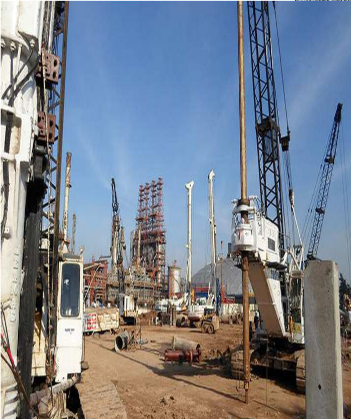
Figura N° 2 Hoyadora para pilotes.
