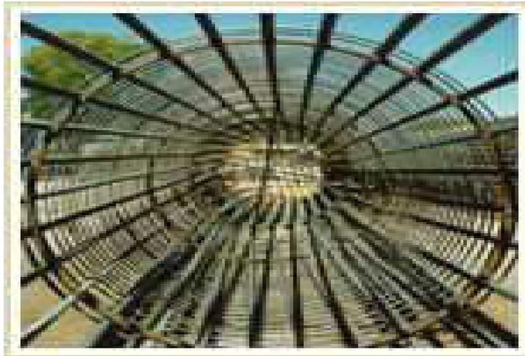
Figura N° 5 Armadura que va dentro de la perforación del pilote
