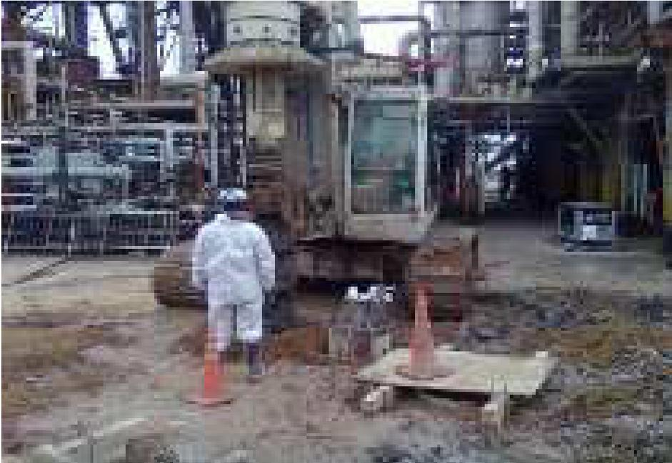
Figura N°3 Posicionamientos de Hoyadora en la planta en proceso. Se posiciona para la realización del comienzo de las excavaciones.
