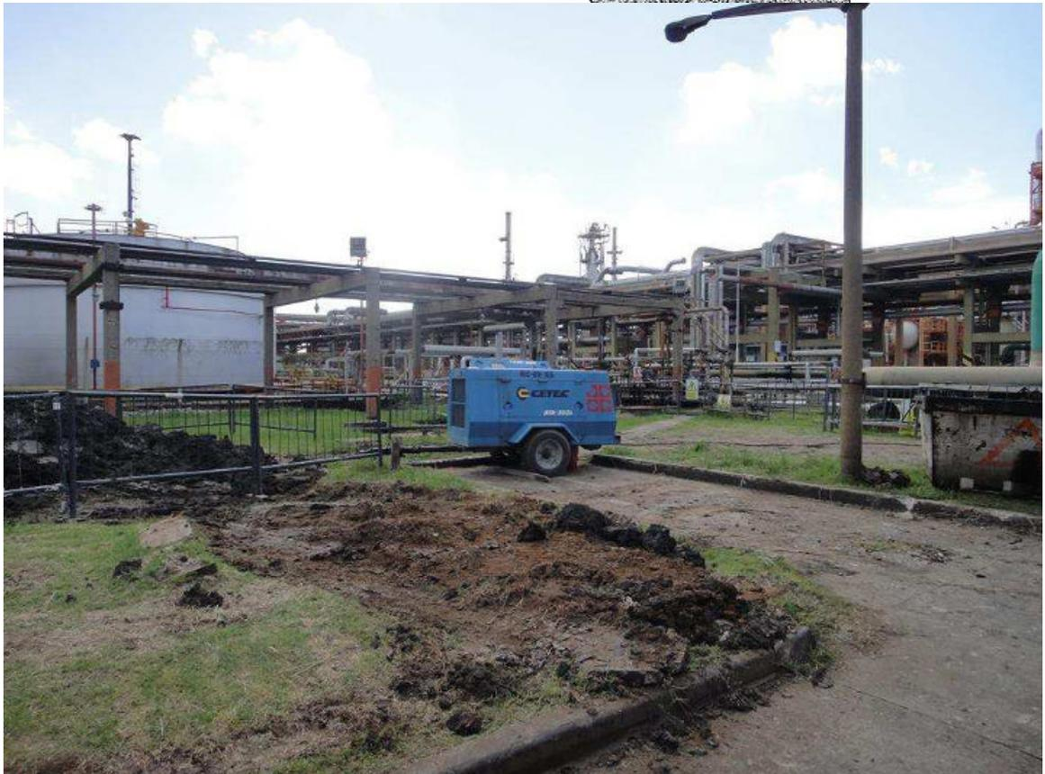
Figura N°19 Zanja Producto de la perforación de la pilotera
