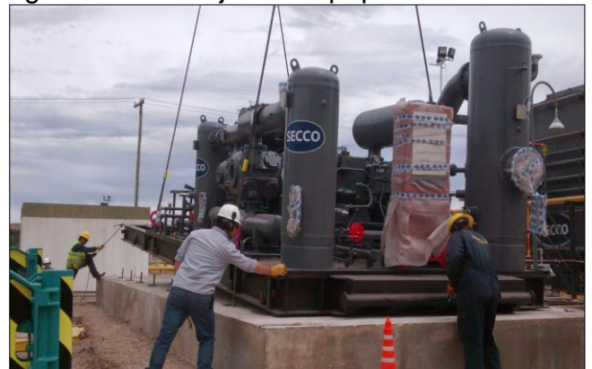
Figura 4. Montaje de Equipos
