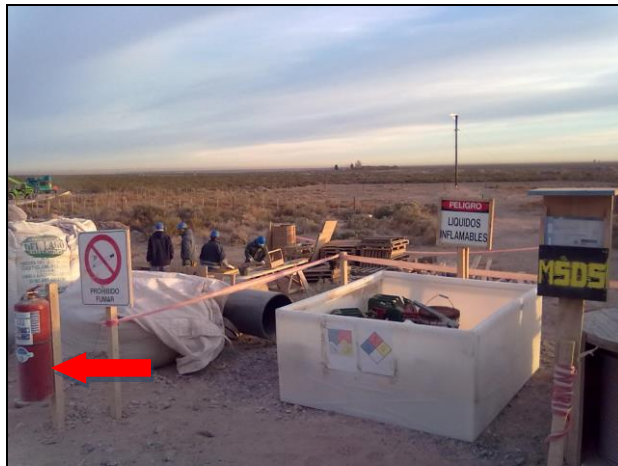
Extintor de polvo químico tipo ABC de 10 kg en sector de almacenamientos de líquidos inflamables.
