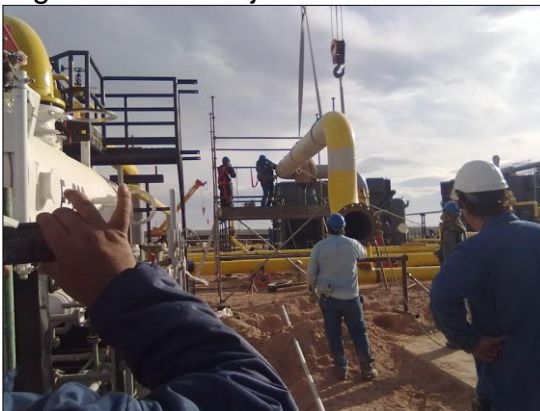
Figura 3. Montaje de Cañerías
