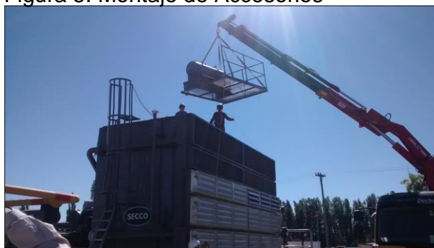
Figura 5. Montaje de Accesorios
