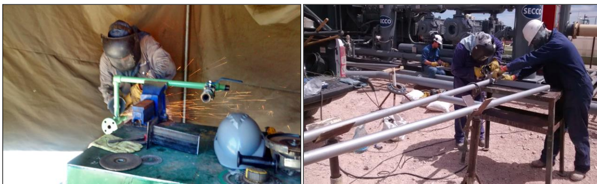
Uso de Amoladora angular de entre 4 ½" y 9" para corte y desbaste.
