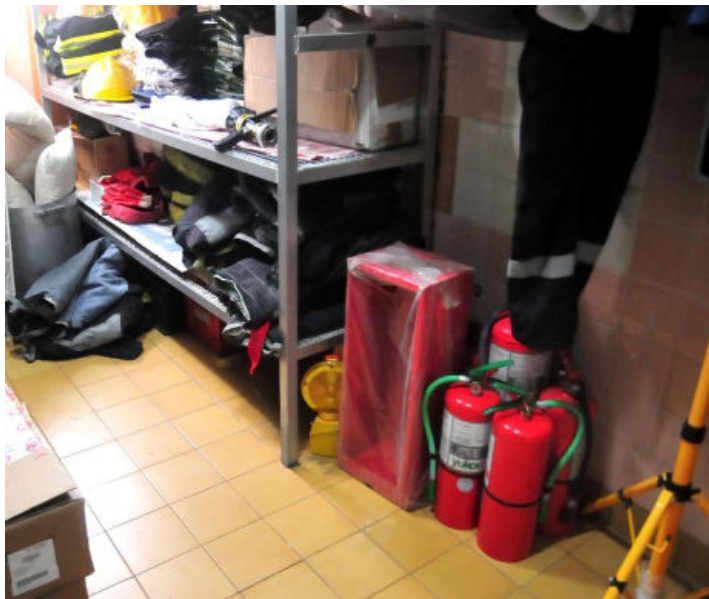
Extintores que fueron comprados nuevos y quedaron en depósito sin distribuir en el establecimiento.
