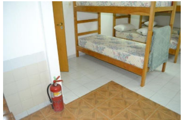
El extintor en el piso dentro del dormitorio. Si bien esta en fecha de uso el mismo no esta colocado tal como lo establece la Norma IRAM 10.005.
