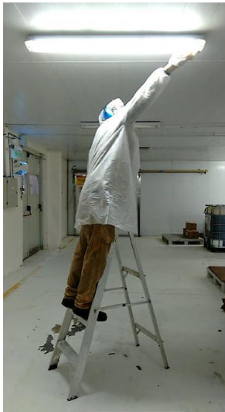
Fig. N° 28 – Limpieza de luminarias.
